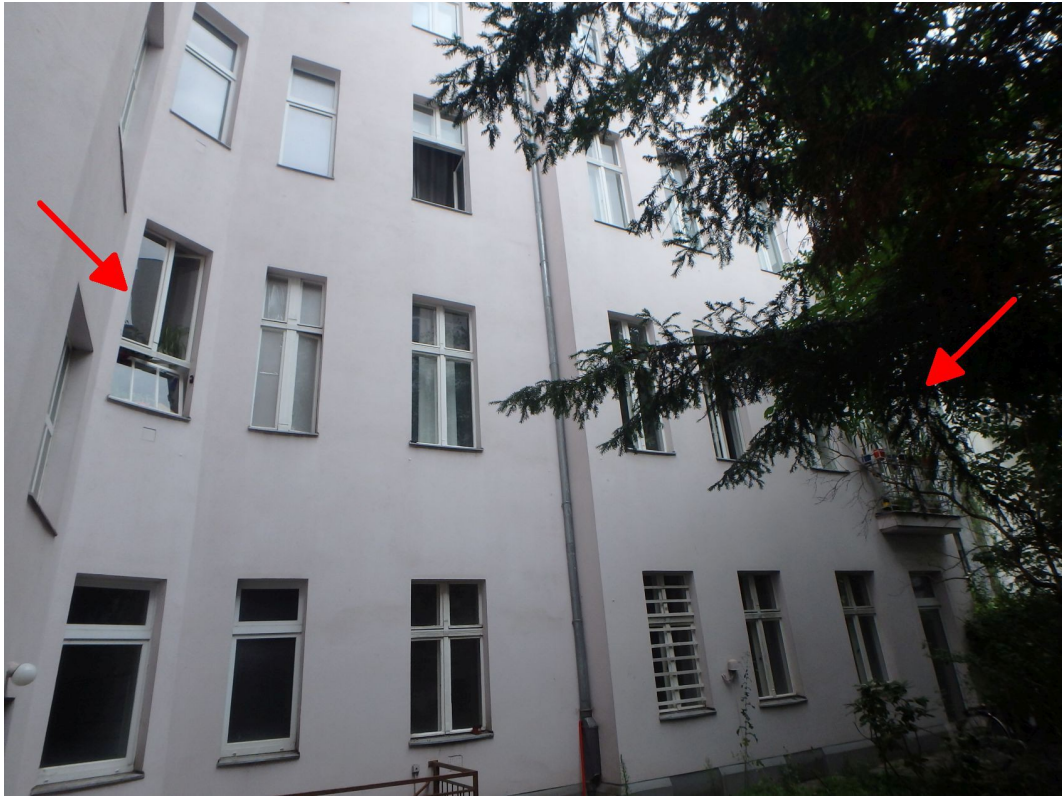
Wohn- und Geschäftshaus (Quergebäude) sowie Eigentumseinheit Nr. 12 Ostansicht (Hofansicht)
