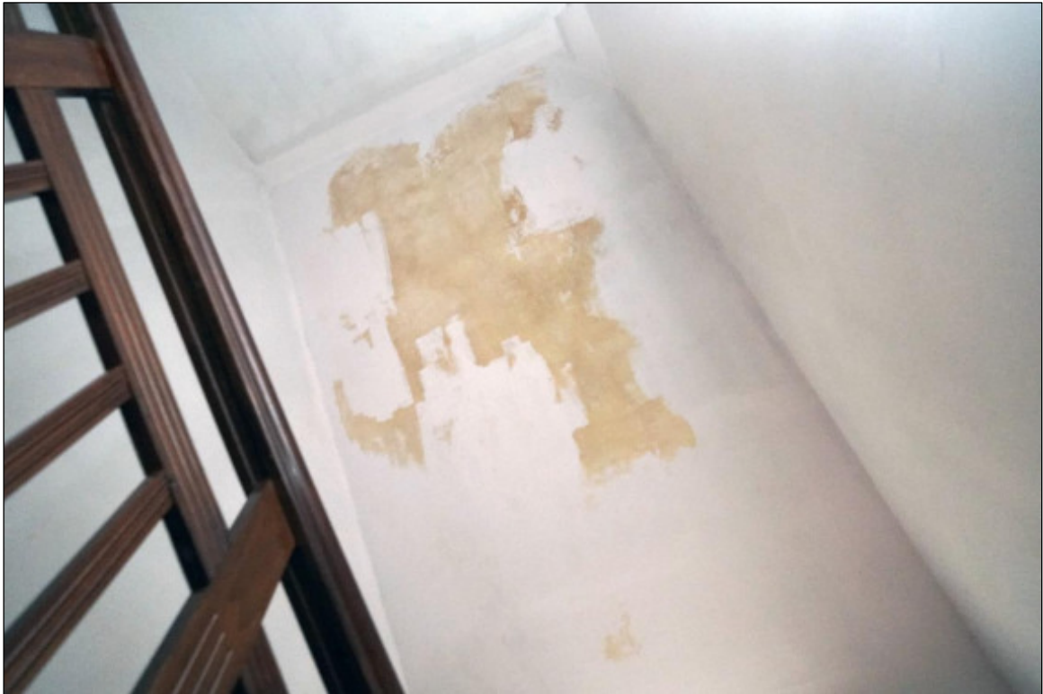
Wasserschaden im Treppenraumkopf (Aufnahme vom 06.11.2024)
