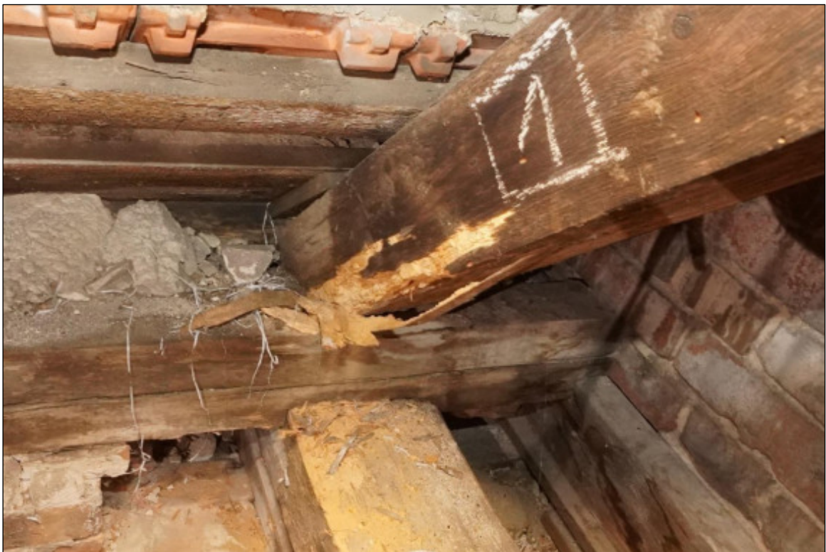
Möglicher Schädlingsbefall im Dachgeschoss (Aufnahme vom 06.11.2024)
