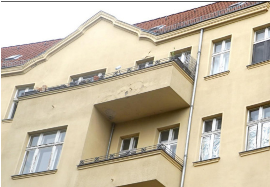
Putzschäden im Fassadenbereich / Balkon
