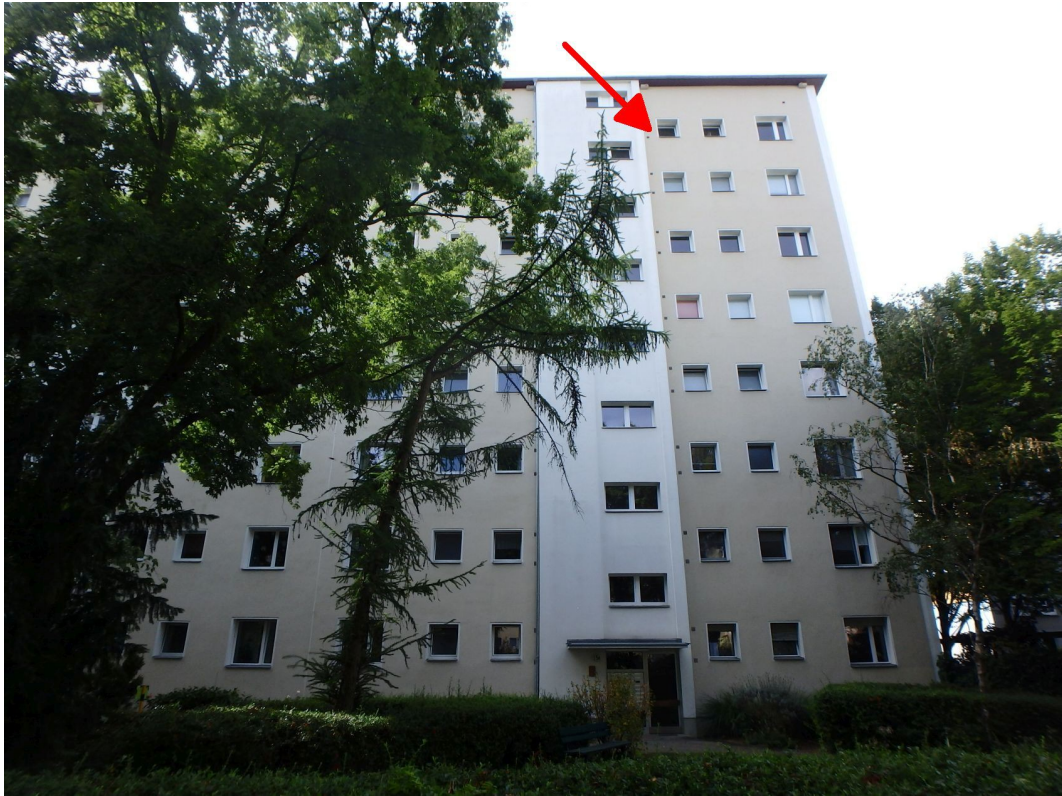
Mehrfamilienwohnhaus (Aufgang Wilhelmsaue 5 A) Ostansicht (Hofansicht)
