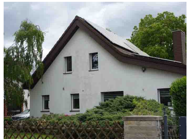
Abb. 14 Blick auf Dachfläche mit PV-Anlage
