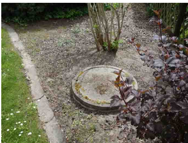
Abb. 15 Abdeckung im Bereich des Vorgartens
