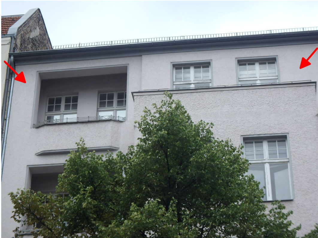
Wohn- und Geschäftshaus sowie Eigentumseinheit Nr. 10 Ostansicht (Straßenansicht)
