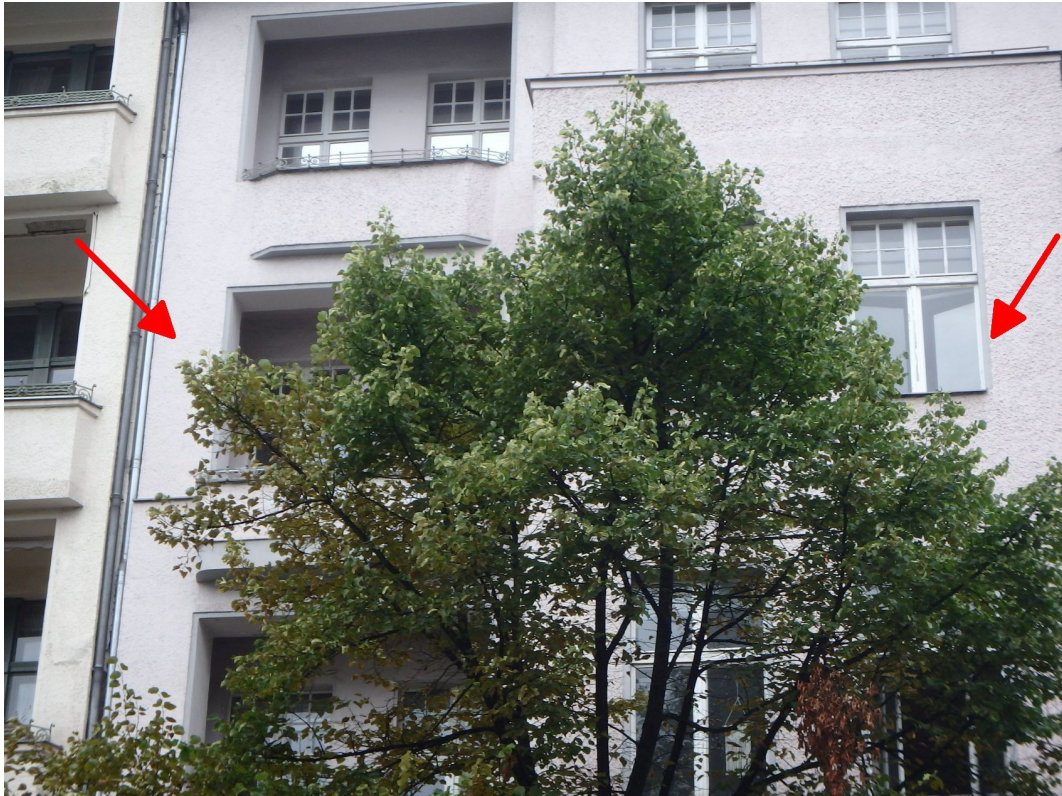
Wohn- und Geschäftshaus sowie Eigentumseinheit Nr. 8 Ostansicht (Straßenansicht)
