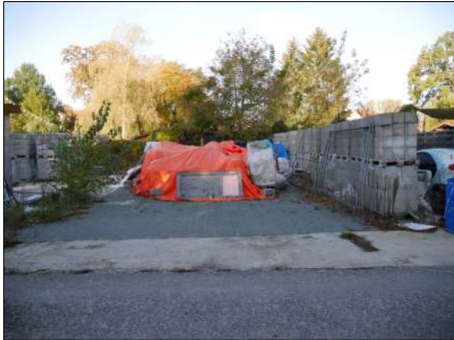
Blick aus dem Straßenraum vor dem Grundstück auf das hier betroffene Grundstück Am Küstergarten 16A mit Nutzung als Lagerfläche für Baustoffe etc.
