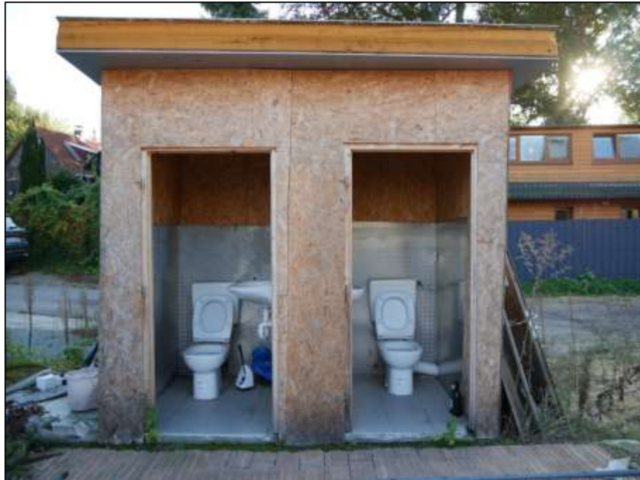
Toilettenschuppen im Bereich der südlichen Grundstücksgrenze des hier betroffenen Grundstücks Am Küstergarten 16A
