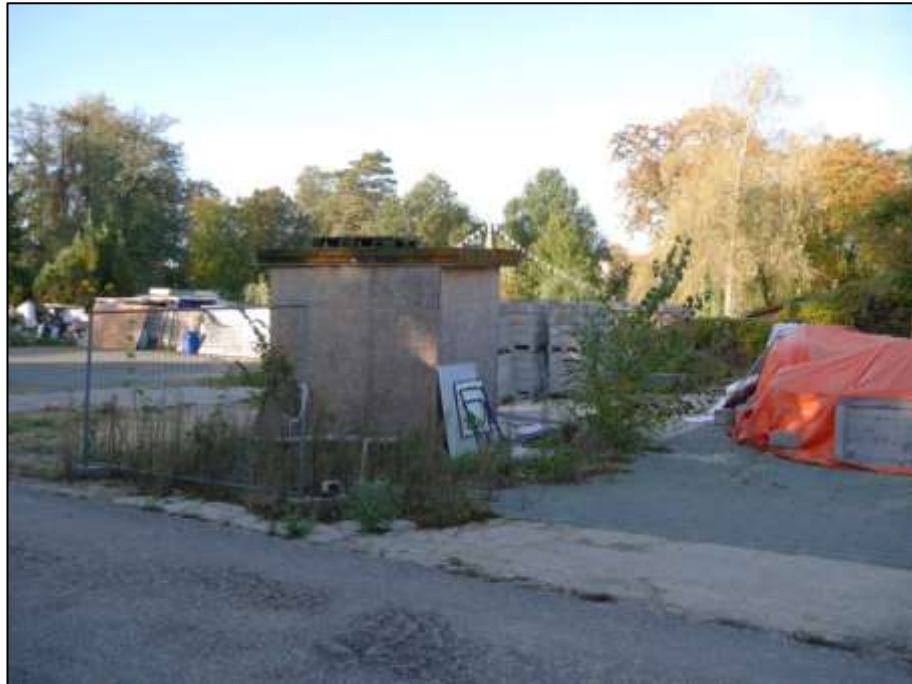
Blick aus dem Straßenraum in den Bereich der südlichen Grundstücksgrenze zu dem angrenzenden Nachbargrundstück Am Küstergarten 18 mit vermtl. noch auf dem hier betroffenen Grundstück Am Küstergarten 16A belegtem Toilettenschuppen
