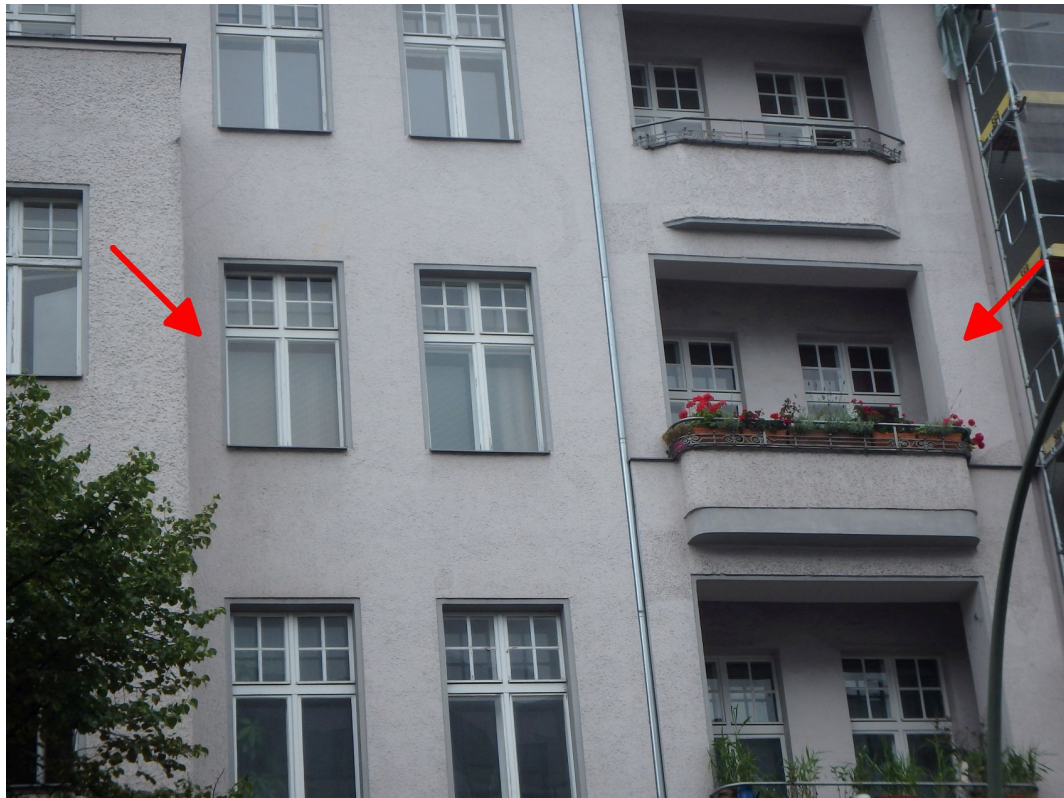
Wohn- und Geschäftshaus sowie Eigentumseinheit Nr. 7 Ostansicht (Straßenansicht)
