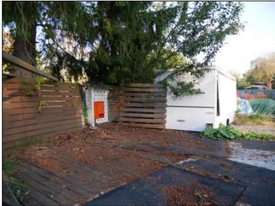
westliche Grundstücksgrenze im Bereich der uferseitigen Grundstücksmaske mit Stromverteilungsanlage und dahinter abgestelltem Gastro- bzw. Ausschankwagen o.ä. auf dem Grundstück Am Küstergarten 18
