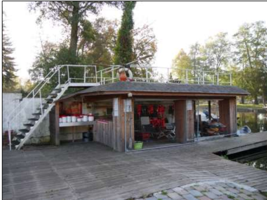
Blick von dem hier betroffenen Grundstück Am Küstergarten 18 auf den Bereich der uferseitigen Grundstücksmaske des westlich angrenzenden Nachbargrundstücks mit Uferkante rechts im Bild und in deren Flucht belegenem Bootsverleih-Schuppen als partieller Überbau a.d. Bewertungsobjekt im vorderen Gebäudeteil mit Treppe auf dessen Dachterrasse
