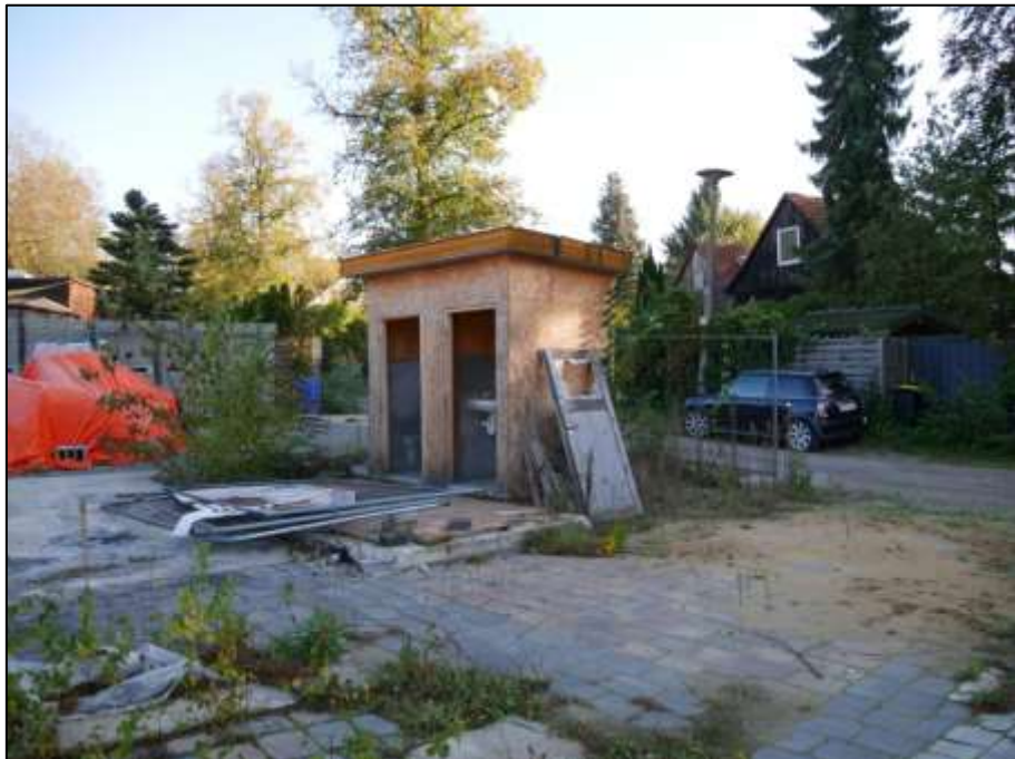
Blick von dem Grundstück Am Küstergarten 18 nach Nord-Osten zur straßenseitigen Grundstücksauffahrt im Bereich des nördlich angrenzenden Nachbargrundstücks Am Küstergarten 16A u.a. mit aufstehendem offenem Toilettenschuppen
