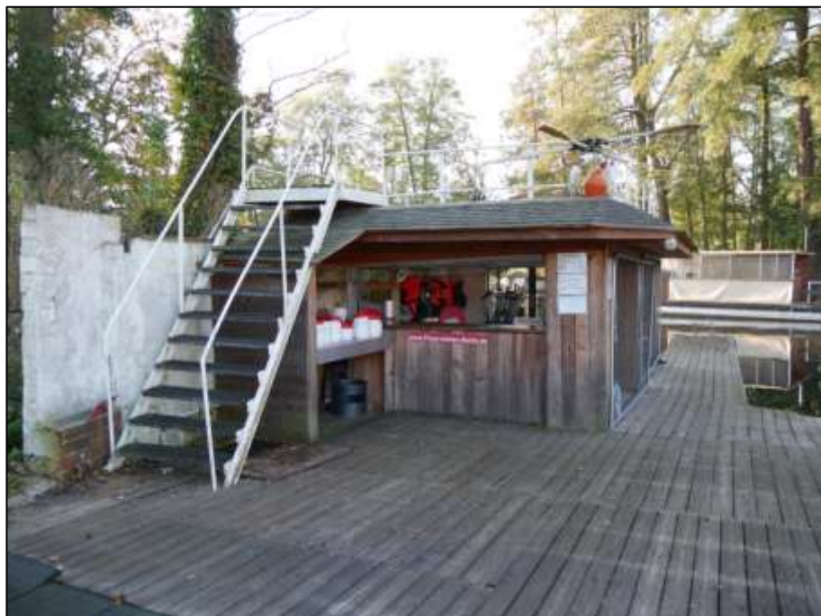
offener Bootsverleih-Schuppen als vermtl. partieller Überbau des hier betroffenen Grundstücks in der süd-östlichen Grundstücksecke mit aufgehender Treppe auf dessen Dachterrasse
