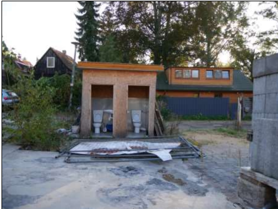
Grenzbereich zwischen den benachbarten Grundstücken Am Küstergarten 16A mit aufstehendem Toilettenschuppen links und südlich angrenzendem Grundstück Am Küstergarten 18 rechts im Bild
