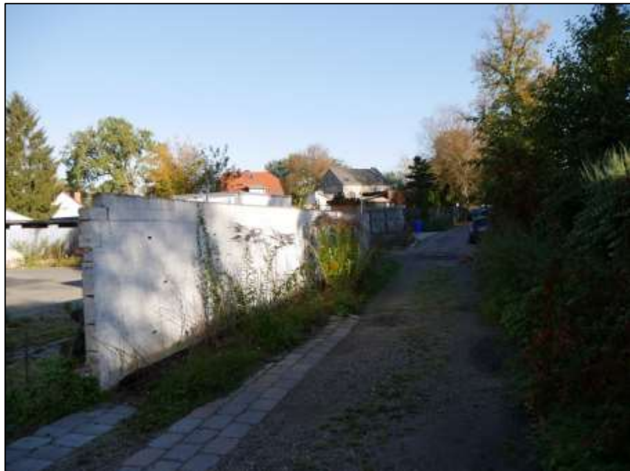
Blick aus der Straße Am Küstergarten auf die dorthin orientierte massive Grenzscheidung des Grundstücks Am Küstergarten 18
