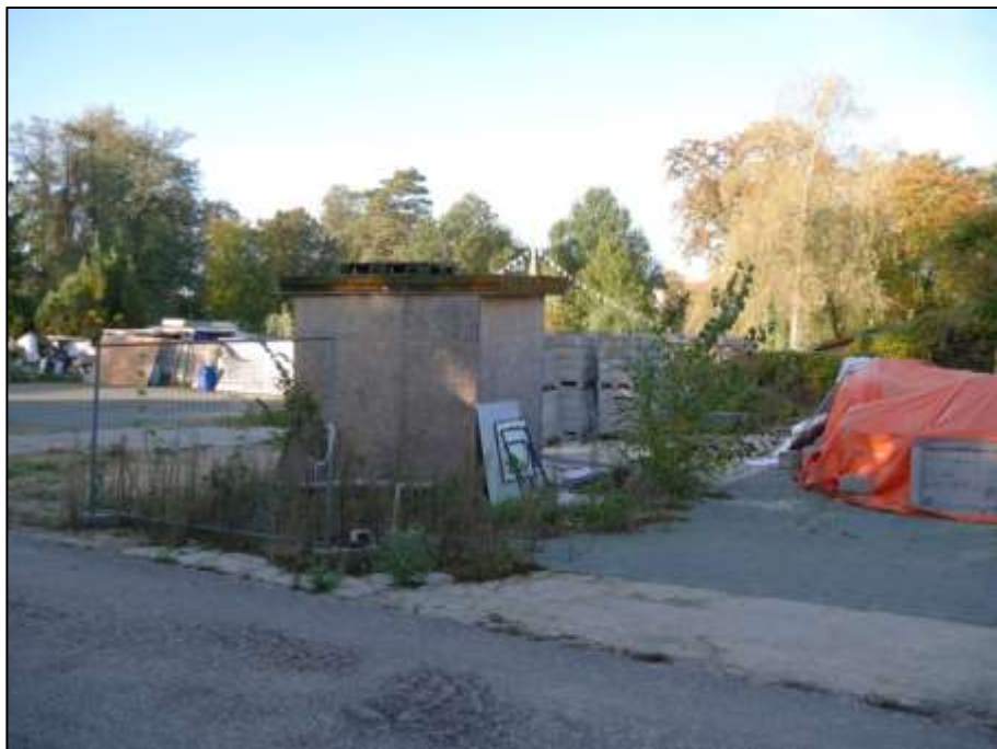
Blick aus der Straße Am Küstergarten nach Süd-Westen auf das Grundstück Am Küstergarten 18 im Bereich der Grundstücksgrenze zu dem davor belegenen Grundstück Am Küstergarten 16A mit aufstehendem offenem Toilettenschuppen (mit Rückseite im Vordergrund)
