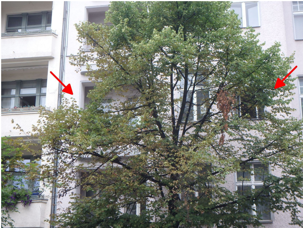
Wohn- und Geschäftshaus sowie Eigentumseinheit Nr. 6 Ostansicht (Straßenansicht)
