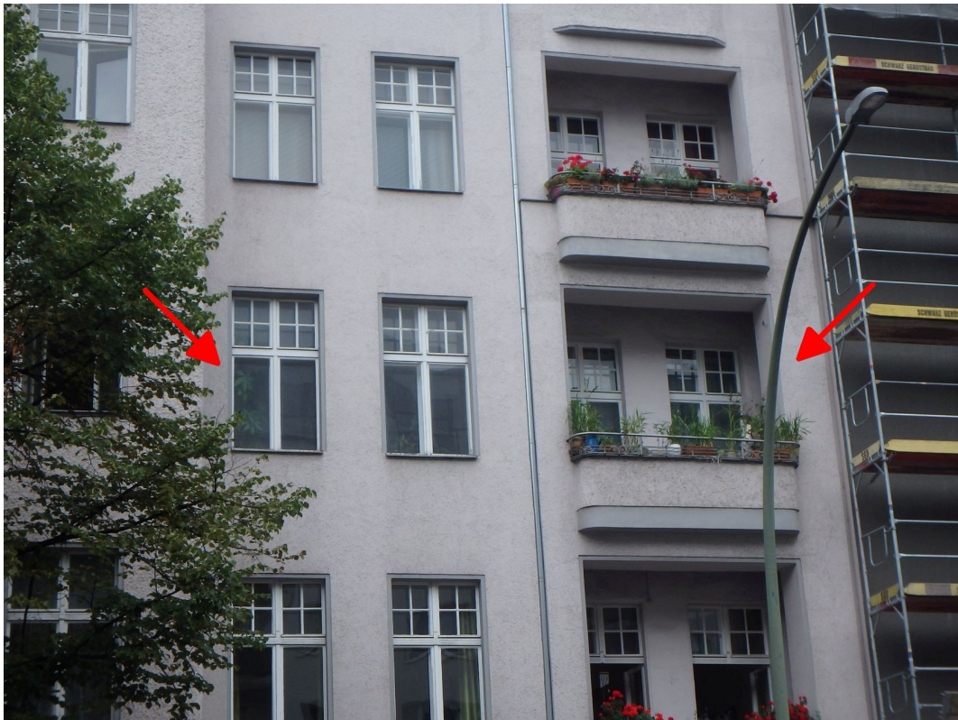
Wohn- und Geschäftshaus sowie Eigentumseinheit Nr. 5 Ostansicht (Straßenansicht)
