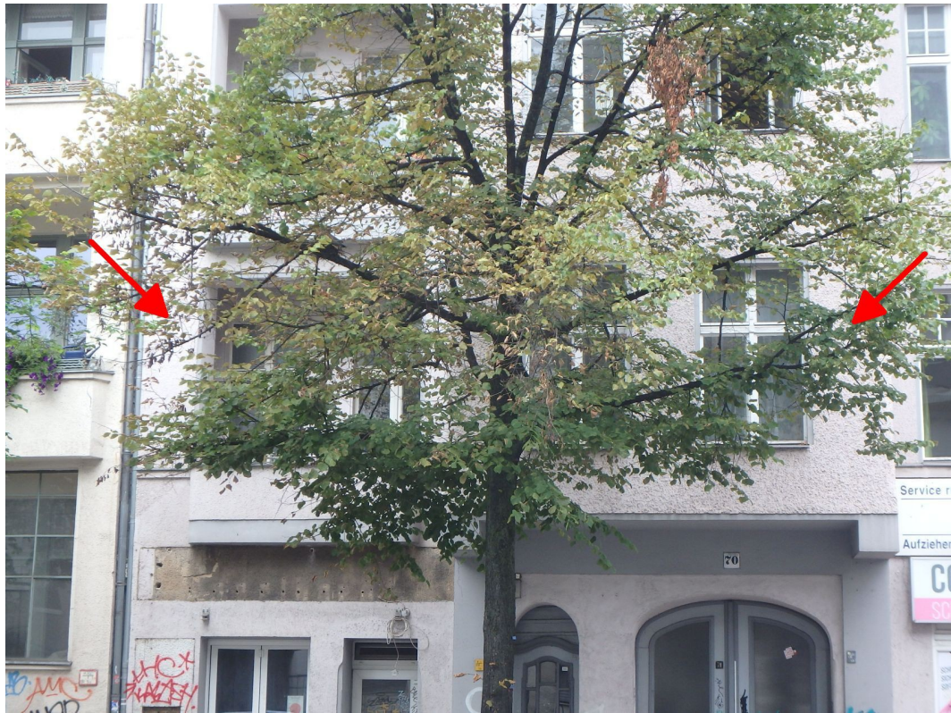
Wohn- und Geschäftshaus sowie Eigentumseinheit Nr. 4 Ostansicht (Straßenansicht)
