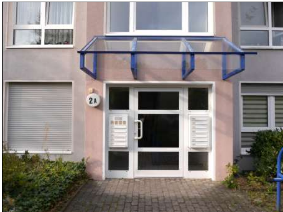
rückwärtiger bzw. gartenseitiger Treppenhauseingang des auf dem Grundstück Platanenweg 2A, 2B aufstehenden Wohngebäudes im Bereich des Treppenhauses des Gebäudeteils Platanenweg 2A
