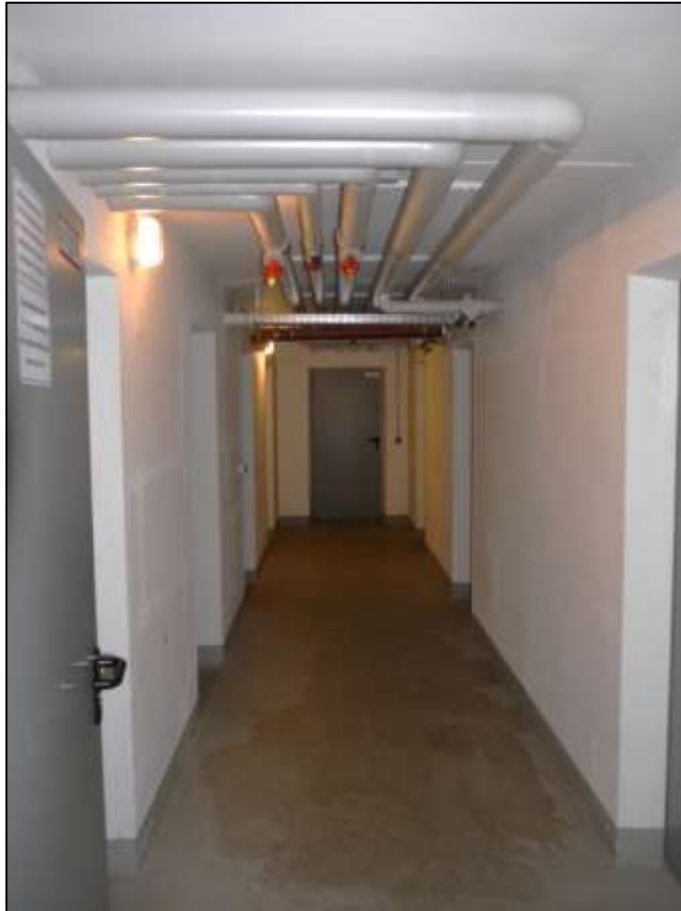
Blick aus der Treppenhausdiele im Kellergeschoss des Gebäudeteils Platanenweg 2A in den postalisch rechts spannenden Zentralflur
