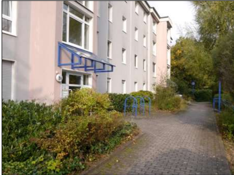
auf das Hochparterre-Niveau angehobene Hauszuwegung vor der rückwärtigen bzw. gartenseitigen Hauseingangsfront des auf dem Grundstück Platanenweg 2A, 2B aufstehenden Wohngebäudes mit Blick nach Nord-Westen - Gebäudeteil Platanenweg 2A im Vordergrund
