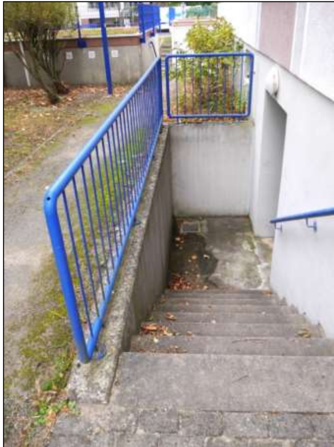
Kelleraußen- treppe vor der süd-östlichen Giebelseite des auf dem Grund- stück Platanen- weg 2A, 2B aufstehenden Wohngebäudes mit Zugang in den im Keller- geschoss belegen- en Zentral- flur
