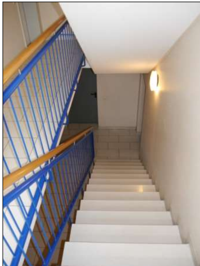
Hauseingangsbereich des Treppenhauses im Gebäudeteil Platanenweg 2A mit offen in das Kellergeschoss abgehendem Treppenlauf
