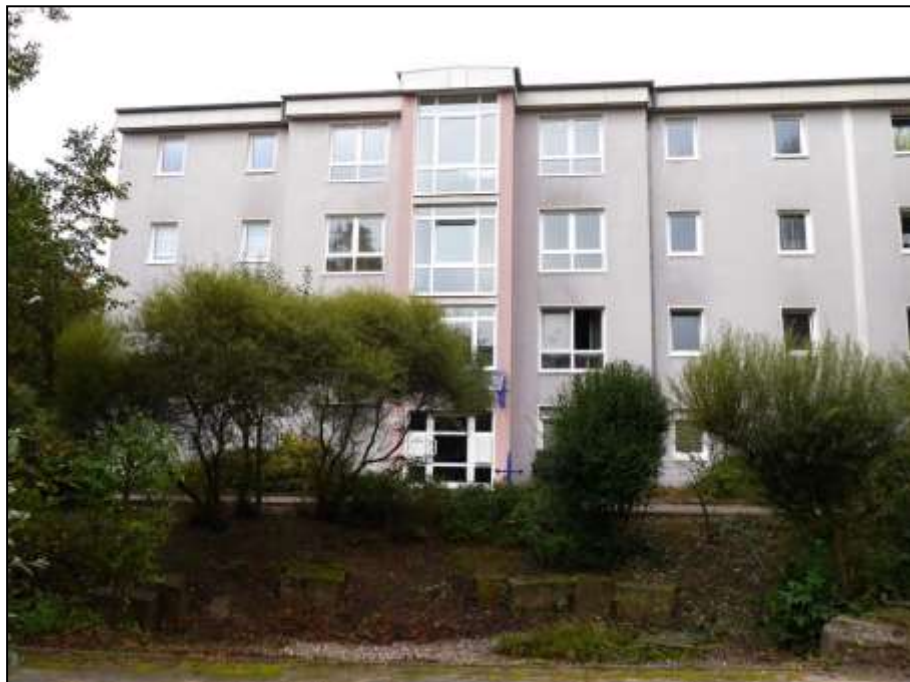
rückwärtige bzw. gartenseitige Hauseingangsfront des auf dem Grundstück Platanenweg 2A, 2B aufstehenden Wohngebäudes
