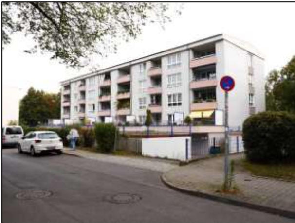
straßenseitige Grundstücksfront mit Rampe
