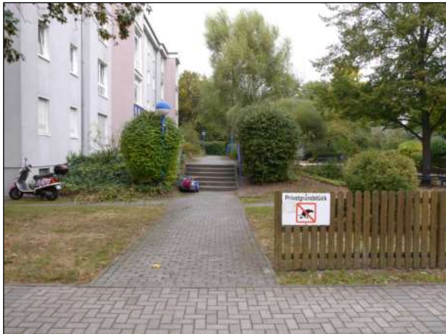
Blick von dem angrenzenden Nachbargrundstück nach Nord-Westen auf die Hauszuwegung mit Differenzterrasse vor der rückwärtigen bzw. gartenseitigen Hauseingangsfront des auf dem Grundstück Platanenweg 2A, 2B aufstehenden Wohngebäudes
