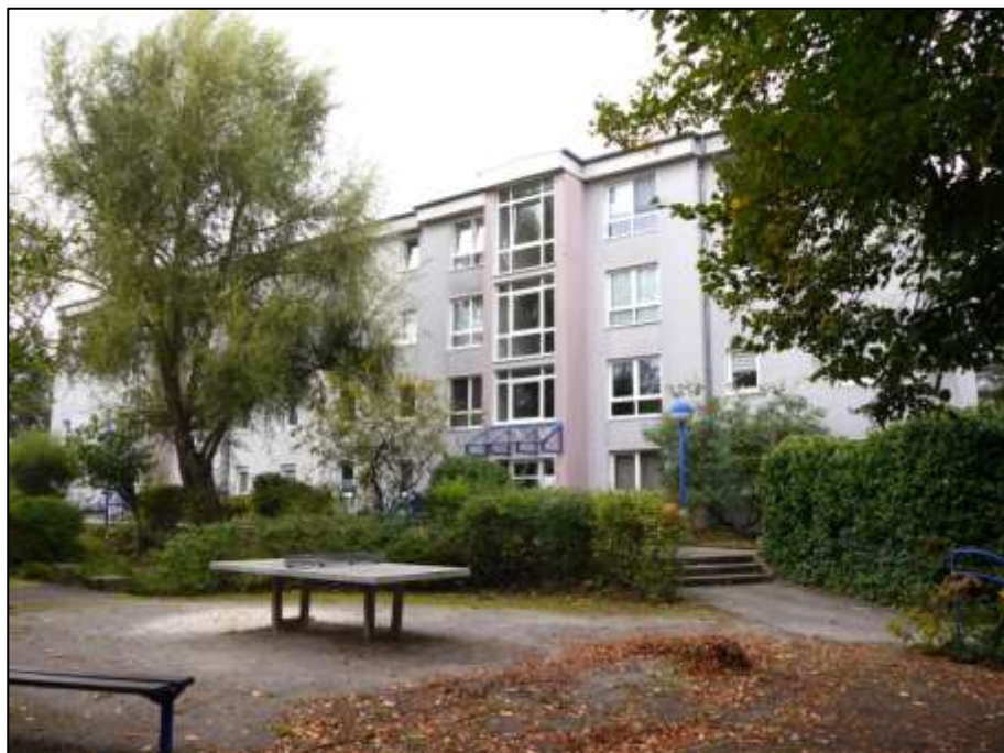
Blick von der auf dem angrenzenden Nachbargrundstück belegenen Privatstraße nach Süden auf die rückwärtige bzw. gartenseitige Haus- eingangsfrent des auf dem Grundstück Platanenweg 2A, 2B aufste- henden Wohngebäudes mit Spielplatzbereich im Vordergrund
