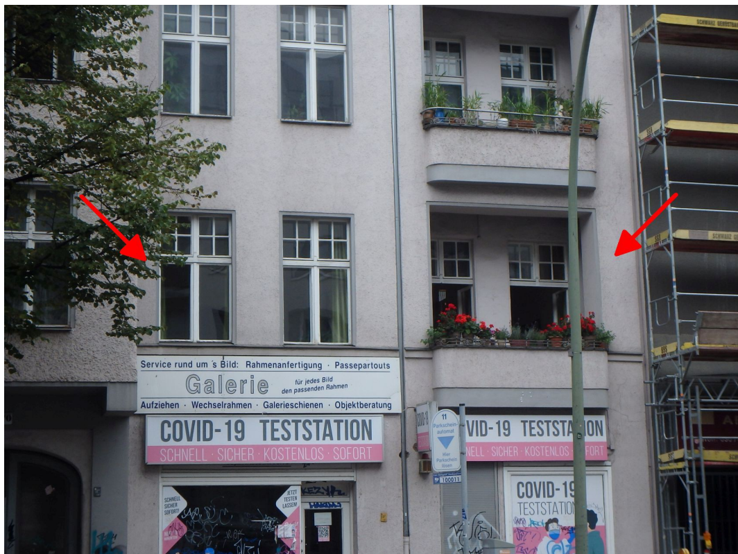
Wohn- und Geschäftshaus sowie Eigentumseinheit Nr. 3 Ostansicht (Straßenansicht)
