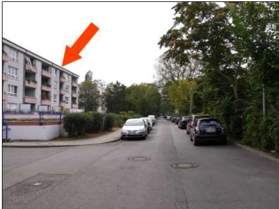
Blick in den Platanenweg nach Süd-Osten mit Lage des Gebäudeteils Platanenweg 2A (Pfeil) auf dem Grundstück Platanenweg 2A, 2B auf der nord-östlichen bzw. im Bild linken Straßenseite - einmündende Privatstraße des Nachbargrundstücks links im Bild
