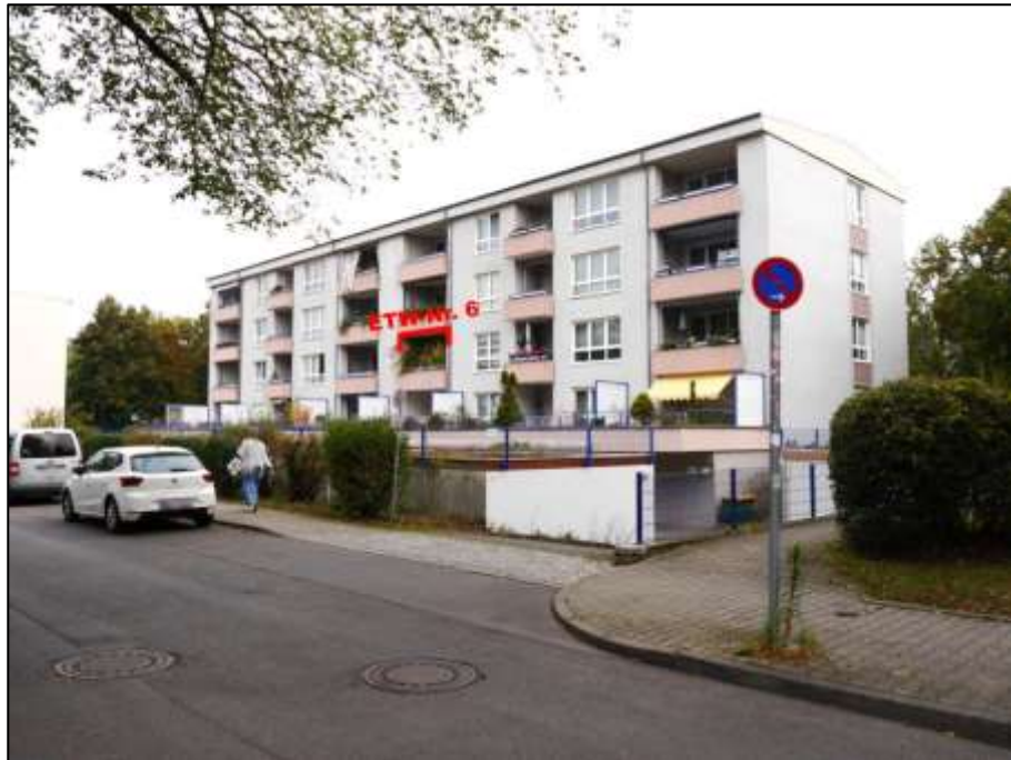
Blick auf das Grundstück Platanenweg mit straßenseitiger Front des aufstehenden Wohnhauses und Lage des Wohnungseigentums Nr. 6 im 1.OG des Gebäudeteils Platanenweg 2A - im Vordergrund: Rampenzufahrt in den Garagenhof vor der straßenseitigen Wohnhausfront mit Kellergaragen und separater Garagenzeile
