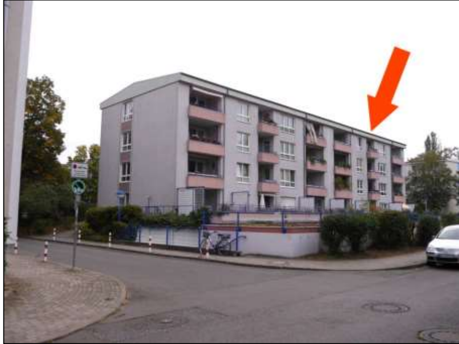
Blick nach Süd-Osten über die in den Platanenweg einmündende Privatstraße des Nachbargrundstücks auf das Grundstück Platanenweg 2A, 2B mit aufstehendem Wohngebäude und Gebäudeteil Platanenweg 2A im Hintergrund (Pfeil)
