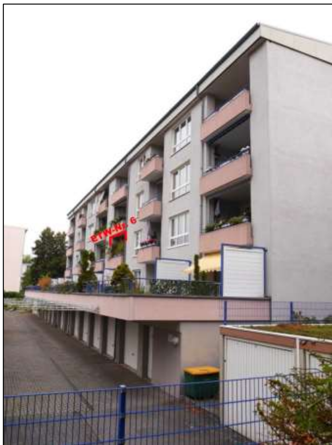
straßenseitige Gebäudefront der Gebäude-teile Platanenweg 2A, 2B mit Lage der ETW-Nr. 6 im 1.OG des Gebäude-teils Platanenweg 2A - Kellergaragen unter dem Erdgeschoss bzw. unterhalb der auskragenden Balkonterrasse im Erdgeschoss
