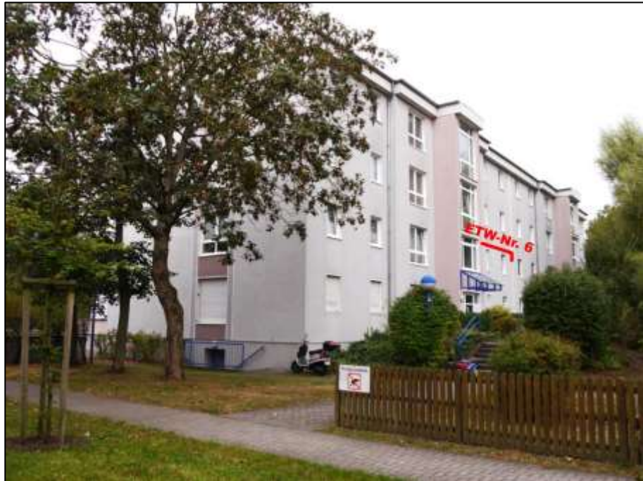
rückwärtige bzw. gartenseitige Hauseingangsfront mit Blick von dem angrenzenden Nachbargrundstück nach Westen mit Lage der ETW-Nr. 6 im 1. Obergeschoss des Gebäudeteils Platanenweg 2A
