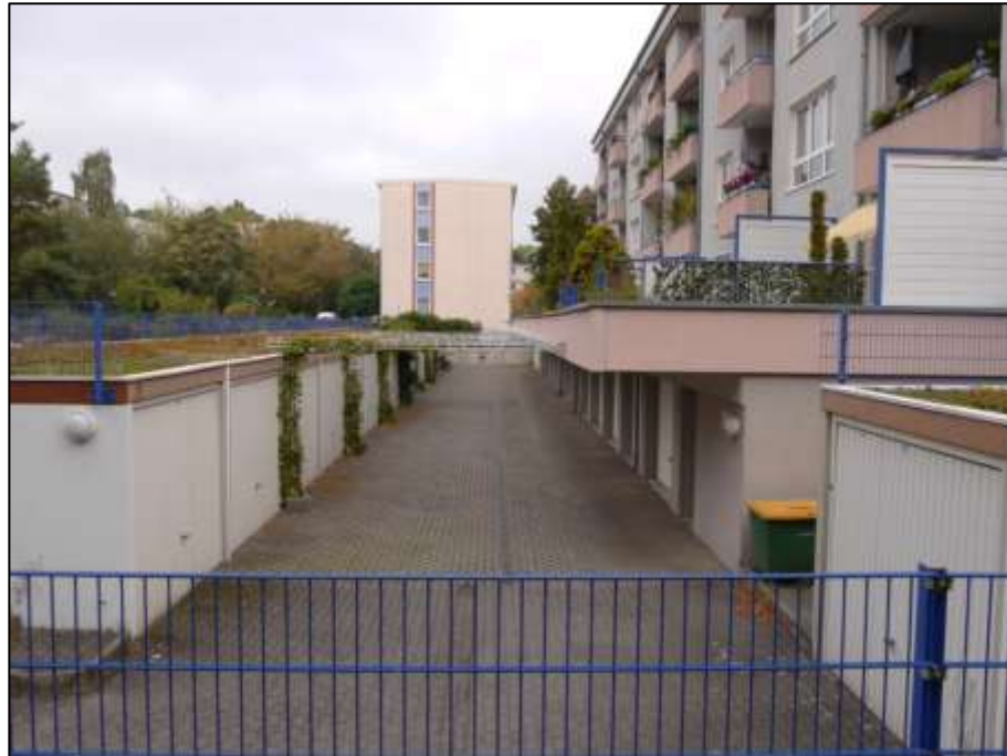
Blick von der Zuwegung auf dem Nachbargrundstück in den Garagenhof nach Nord-Westen mit Kellergaragen rechts und separater Garagenzeile links im Bild
