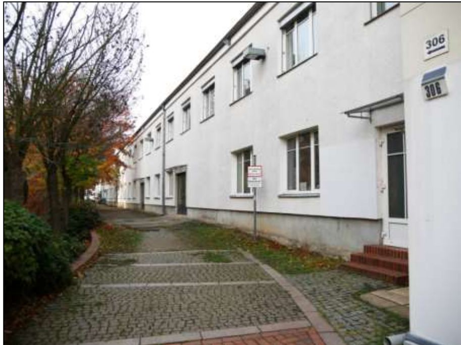
zur Wohnanlage orientierte südliche Front der ursprünglichen Produktionshalle mit 2-geschossigem Büro- und Lagerflächen-Einbau
