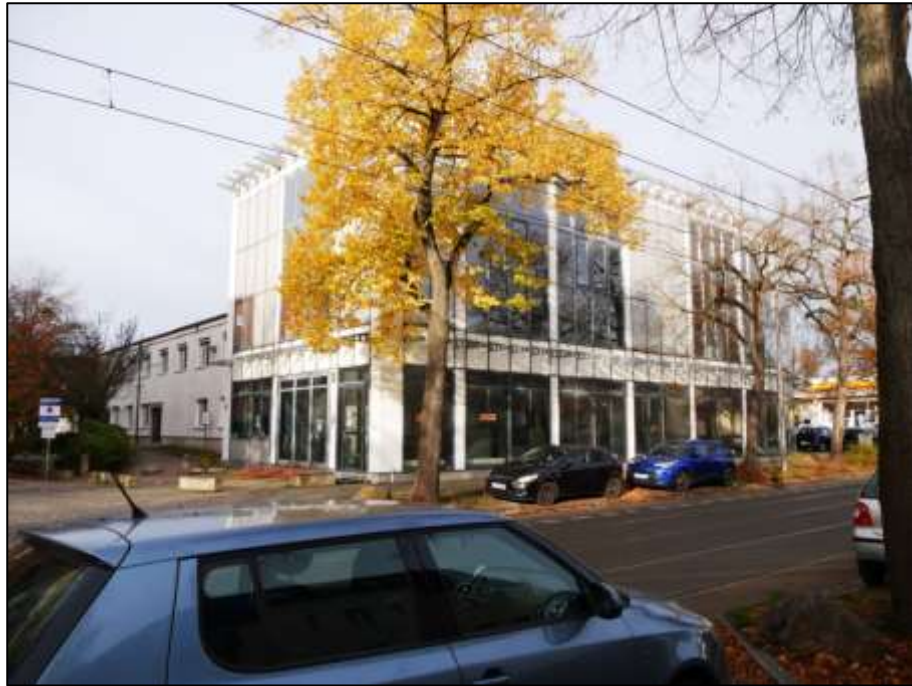
Halle mit 2-geschossigem Teileinbau und straßenseitigem Kopfgebäude als gewerblicher Ausstellungsbau auf dem hier betroffenen Grundstück
