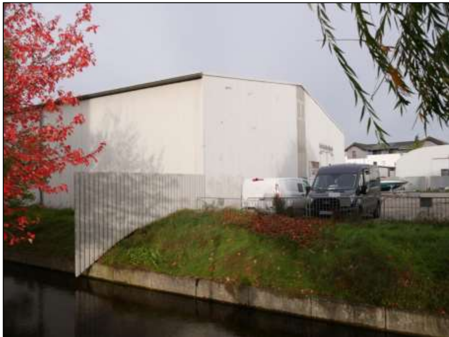
Wassergraben zwischen dem Wohngrundstücksteil und dem Hallenteil des Grundstücks mit neuer uferseitiger Halle
