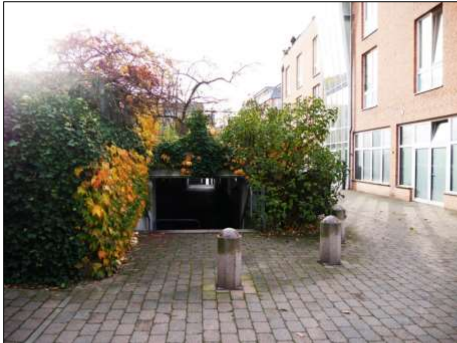
Zugang im Bereich der westlichen Kopfseite der zentralen in dem Gebäudekomplex belegenen Tiefgarage
