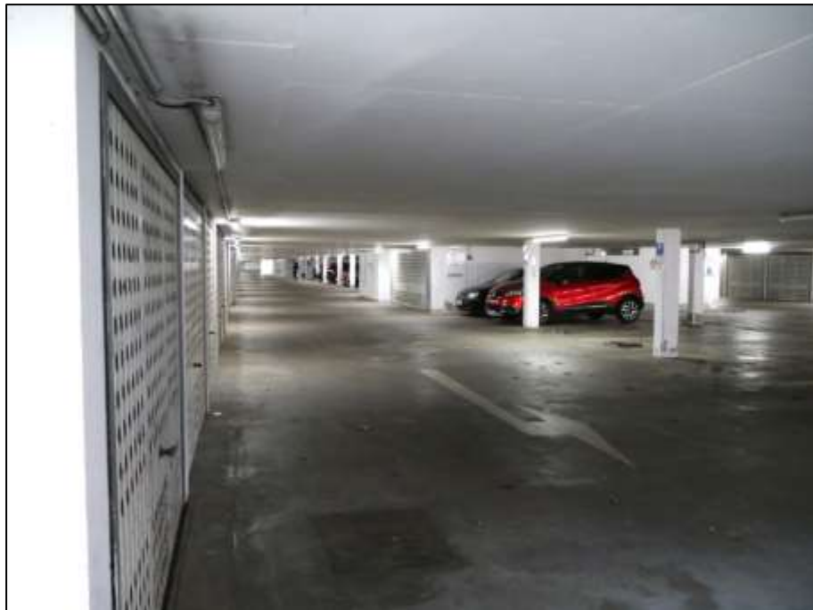
zentrale in dem Gebäudekomplex belegene Tiefgarage
