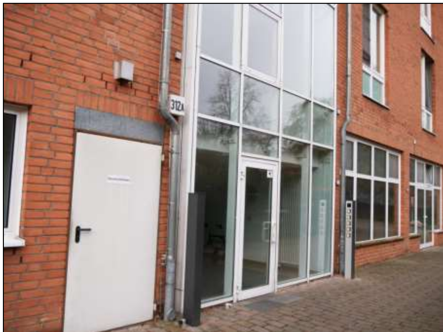
Hauseingangsfrent mit anbindendem Treppenhausaufgang Wendenschloßstraße 312A
