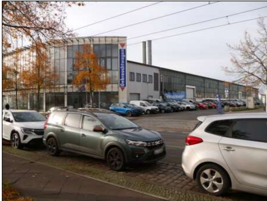
Blick über die Wendenschloßstraße auf das straßenseitige Kopfgebäude als gewerblicher Ausstellungsbau der dahinter anbindenden früheren Produktionshalle auf dem hier betroffenen Grundstück
