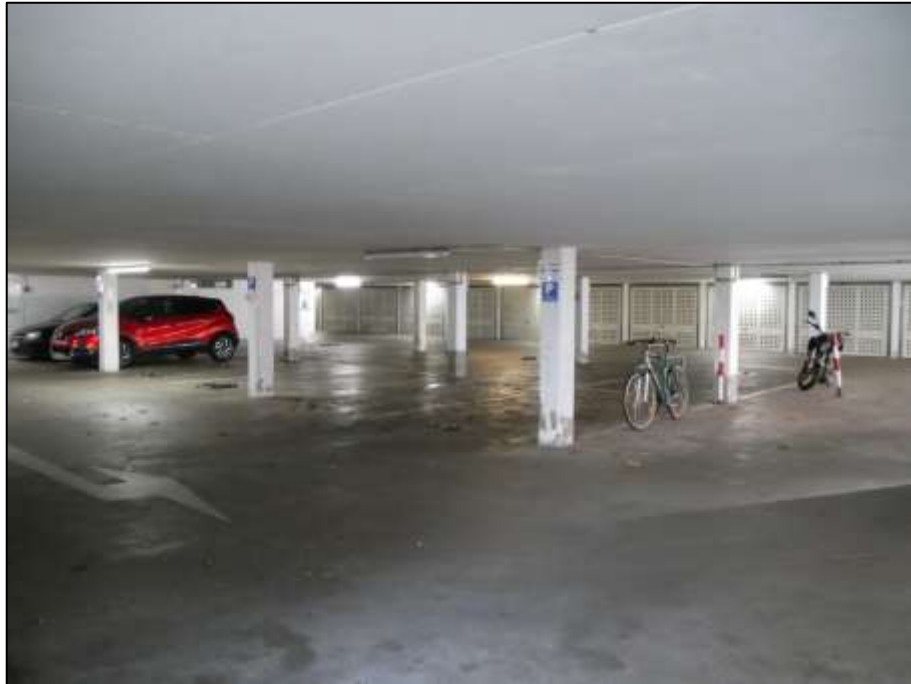
zentrale in dem Gebäudekomplex belegene Tiefgarage
