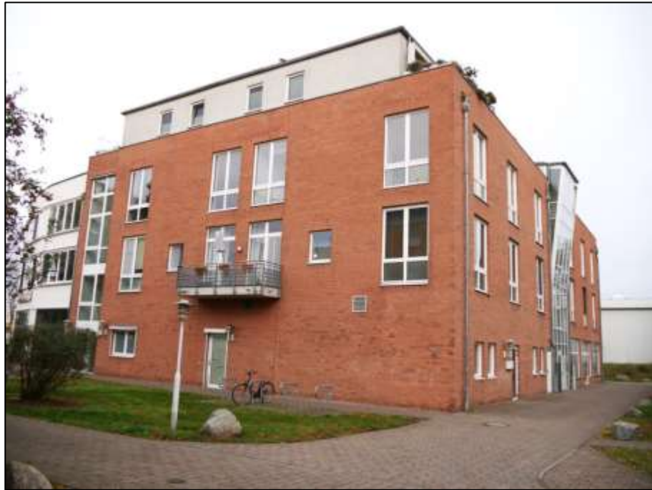
Blick auf die südliche Front des uferseitigen Gebäudes Wendenschloßstraße 312A, 312B und 312C mit Treppenhauseingang Wendenschloßstr. 312B sowie östliche Gebäudefront mit Treppenhauseingang Wendenschloßstr. 312A rechts im Bild
