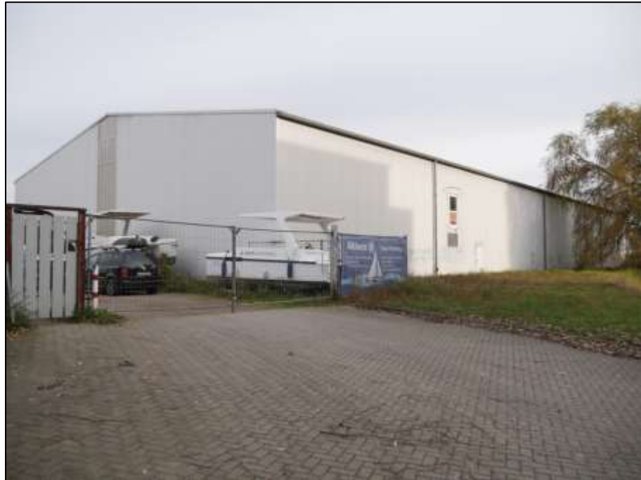
westliche Giebelseite der uferseitigen Bootshalle auf dem hier betroffenen Grundstück
