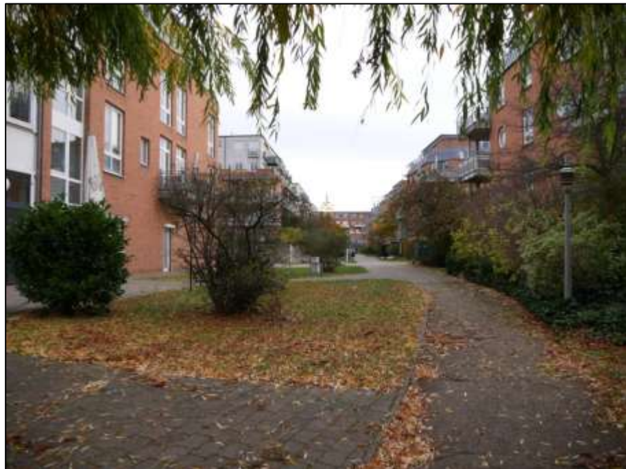
Blick aus dem Bereich der uferseitigen Front des Gebäudeteils Wendenschloßstraße 312A, 312B und 312C in den Blockinnenbereich nach Osten mit Lage des Gebäudeteils Treppenhauseingang Wendenschloßstr. 312B links im Bild
