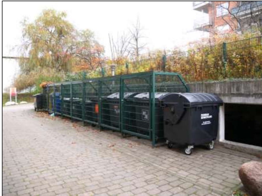
Müllgefäßstellplatzfläche vor der Hauseingangsfrent mit anbindendem Treppenhausaufgang Wendenschloßstraße 312A
