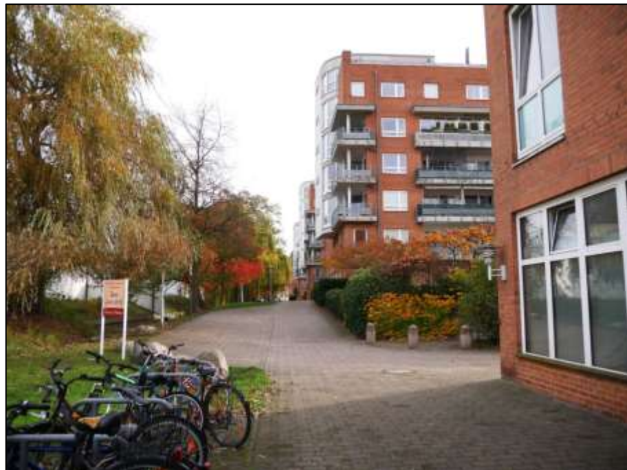
Blick aus dem Uferbereich Bereich des Gebäudeteils Wendenschloßstraße 312A, 312B und 312C in den rechten Bauwich des Wohngebäudekomplexes mit links im Bild anbindendem Wassergraben zwischen dem Wohngrundstücksteil und dem Hallenteil des Grundstücks
