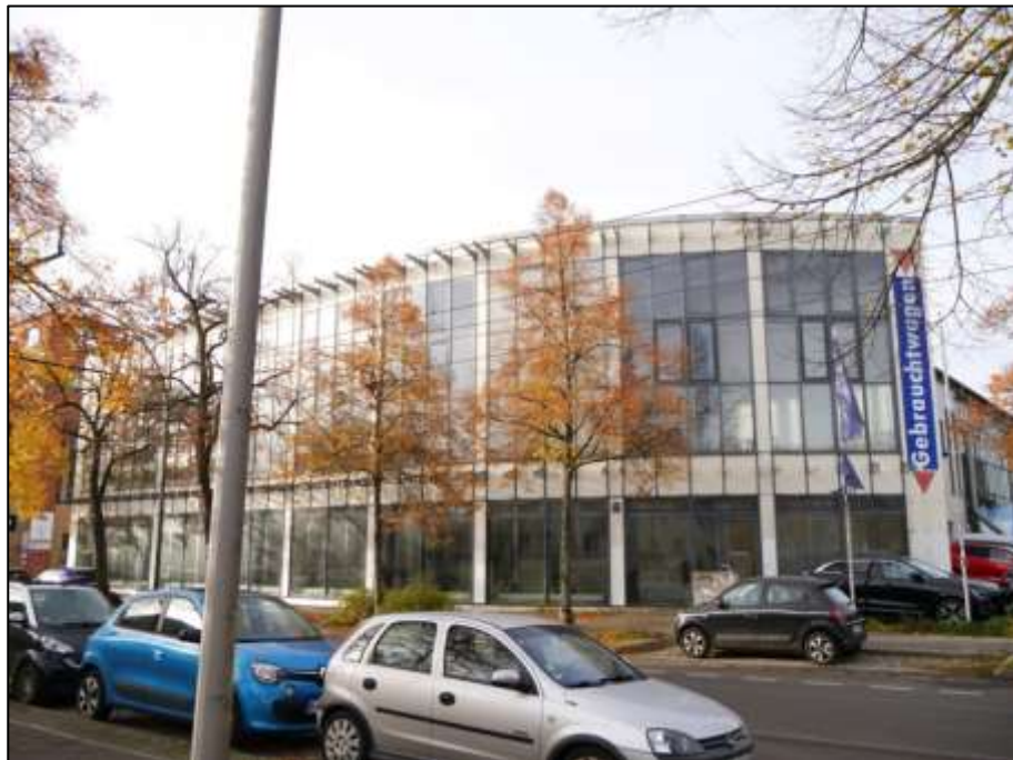
straßenseitiges Kopfgebäude der früheren Produktionshalle als gewerblicher Ausstellungsbau auf dem hier betroffenen Grundstück
