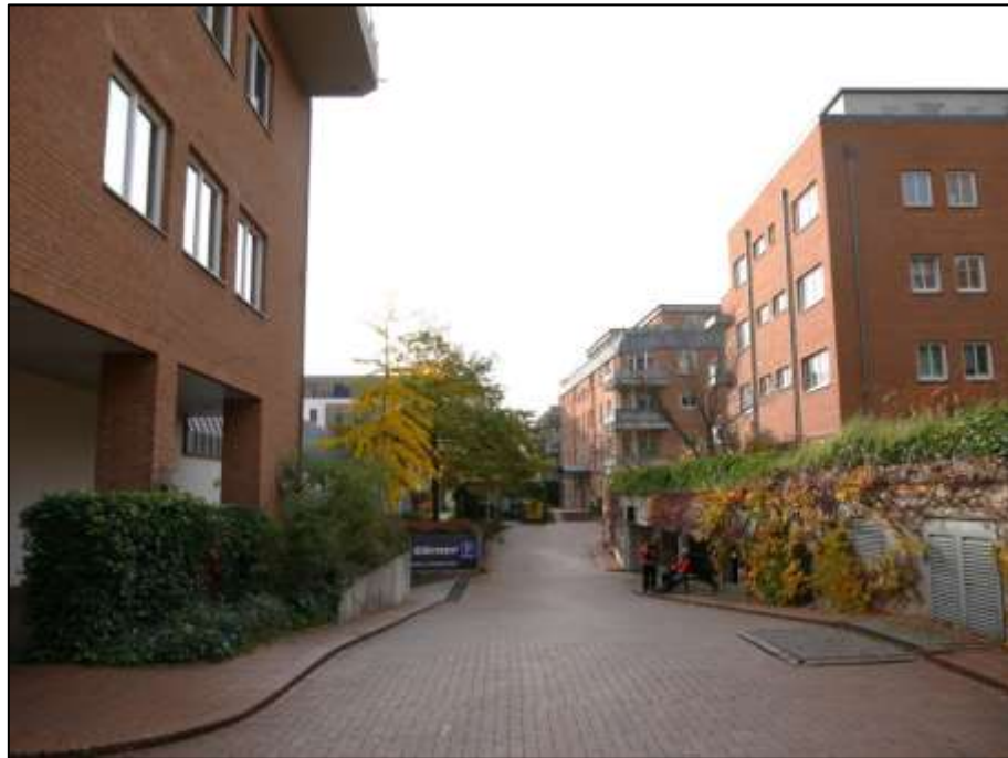
Zugang und Zufahrt u.a. zur Tiefgarage im Blockinnenareal hinter der straßenseitigen Blockrandbebauung des Wohngebäudekomplexes auf dem hier betroffenen Grundstück
