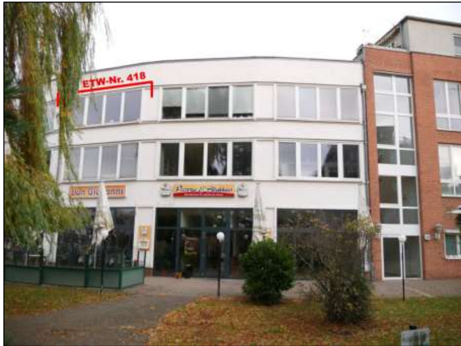
uferseitige Front des Gebäudeteils Wendenschloßstraße 312A, 312B und 312C mit Lage der ETW-Nr. 418 im 2.OG
