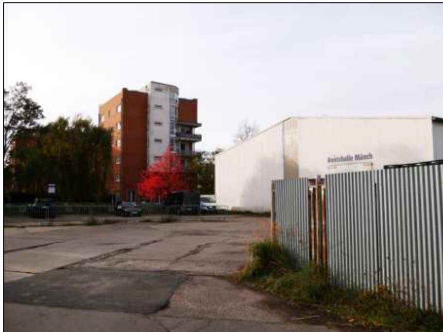
Blick über ein nördlich angrenzendes Nachbargrundstück (Flurstück 8581) auf das auf dem hier betroffenen Grundstück (Flurstück 152/4) aufstehende uferseitige Hallengebäude
