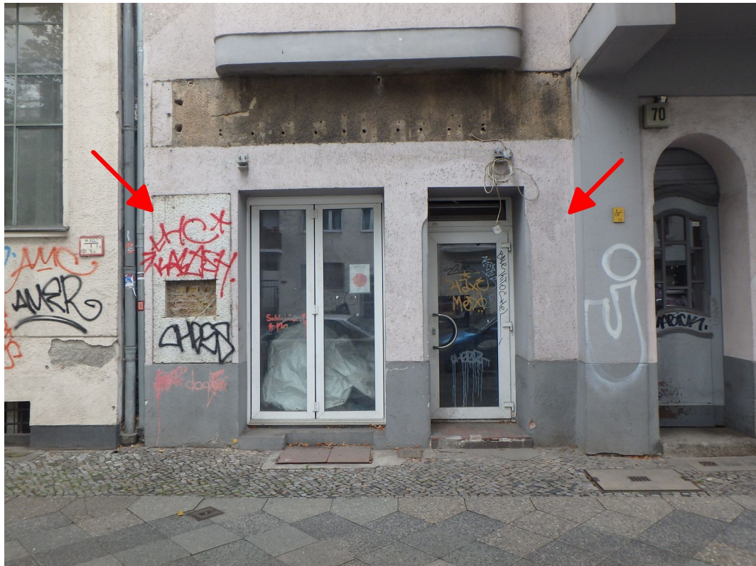
Wohn- und Geschäftshaus sowie Teileigentumseinheit Nr. 1 Ostansicht (Straßenansicht)
