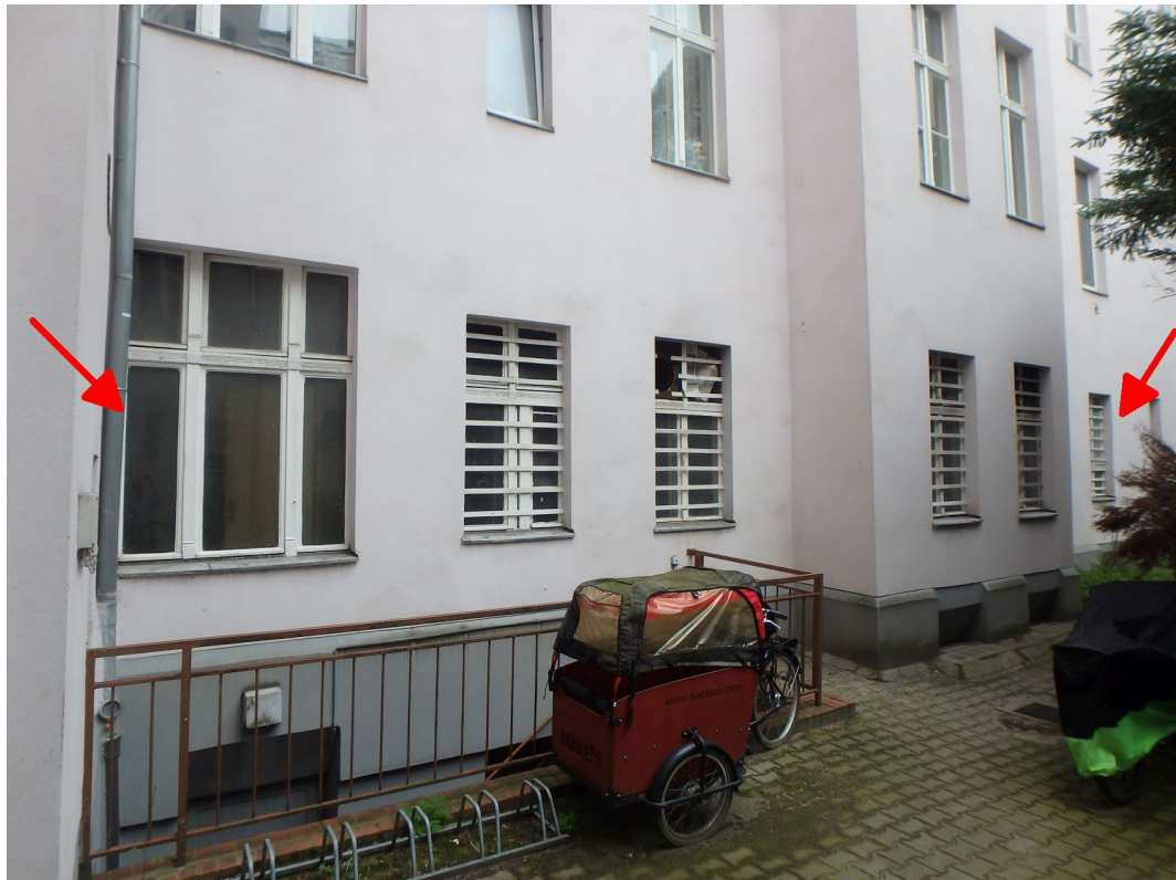
Wohn- und Geschäftshaus (Seitenflügel) sowie Teileigentumseinheit Nr. 1 Nordostansicht (Hofansicht)
