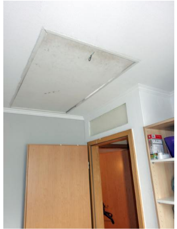
Klappe mit Auszugstreppe vom DG zum Spitzboden
