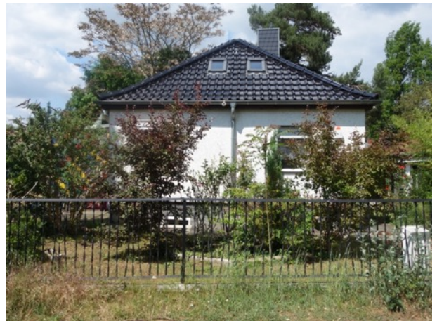
Abb. 15 Ansicht von der Pritstabelstraße aus
