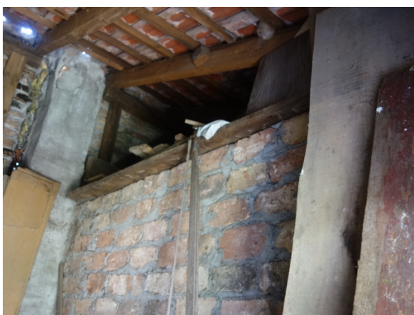
Abb. 60 Innenansicht massiver Schuppen
