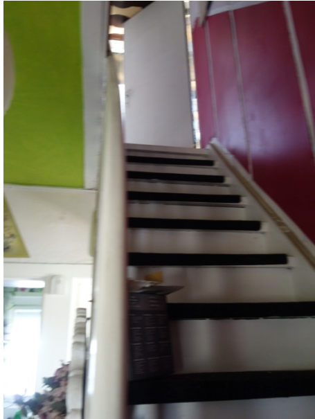
Abb. 44 Treppe zum DG
