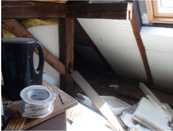
Abb. 50 nicht ausgebauter Dachraum
