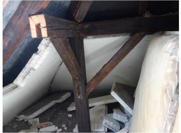
Abb. 51 nicht ausgebauter Dachraum
