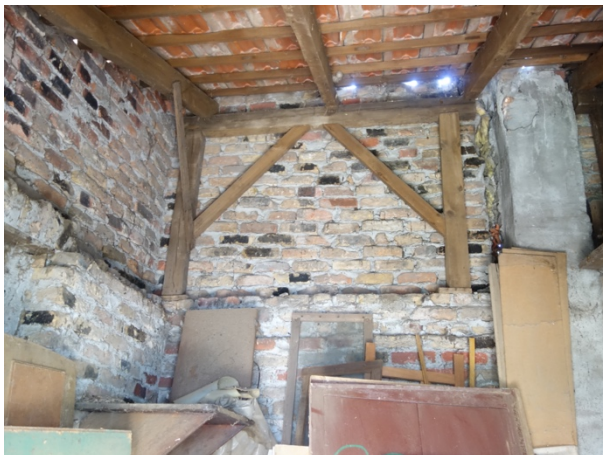
Abb. 58 Innenansicht massiver Schuppen
