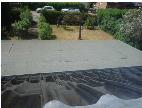
Abb. 48 Blick aus Gaube auf Wintergardendach
