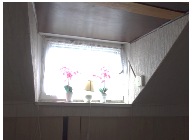
Abb. 47 Gaube im ausgebauten Raum DG
