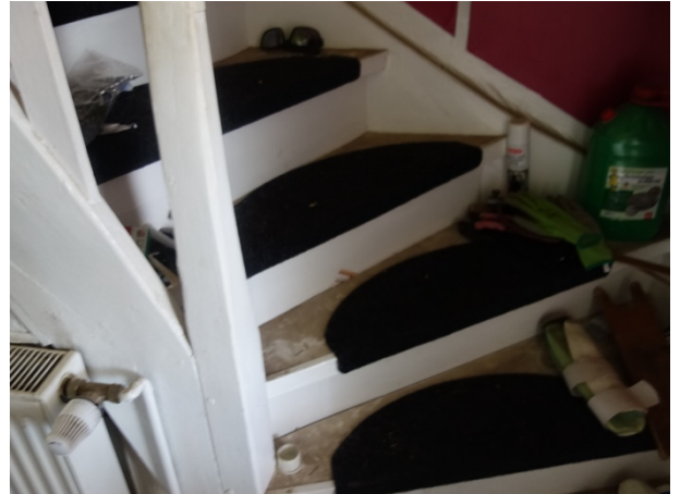
Abb. 45 Treppe zum DG
