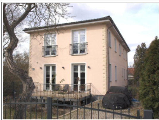
straßenseitige Ansicht des Einfamilienhauses
