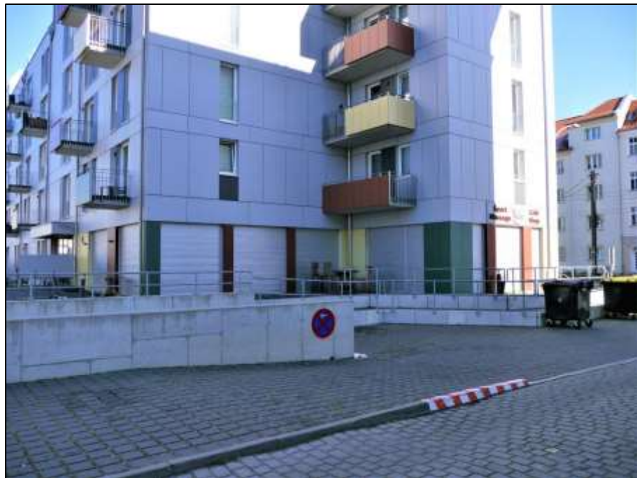
freie Giebelseite und rückwärtige Front des Gebäudeteils Lindenstr. 28A
