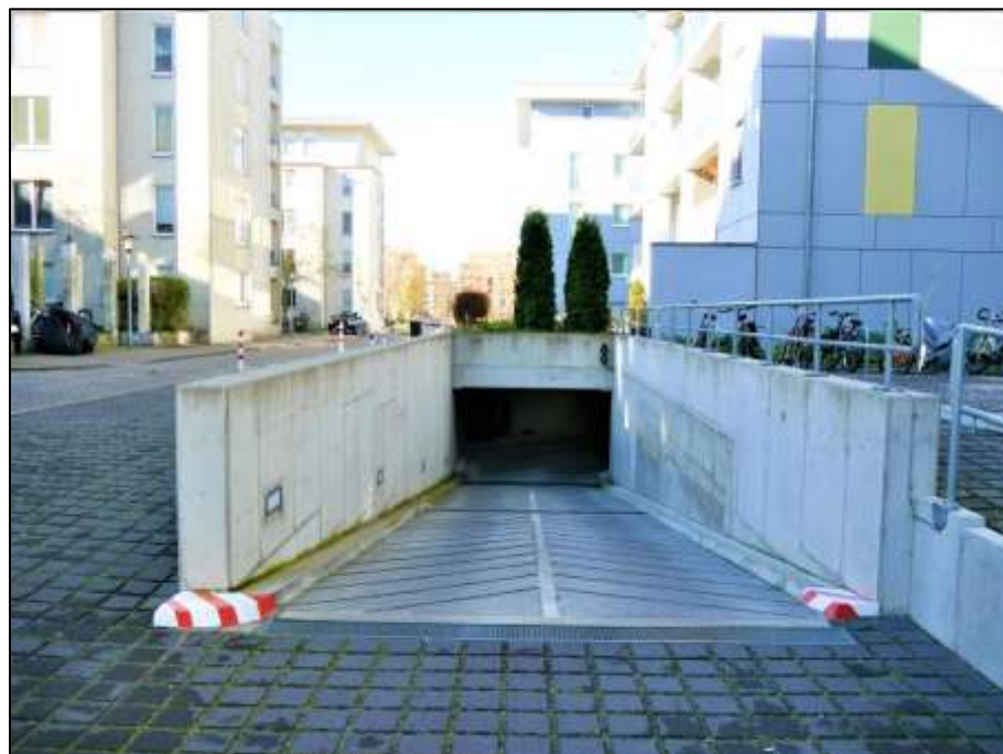
Blick auf die Rampen-Ein- und Ausfahrt der Tiefgarage auf dem Grundstück sowie die Durchwegung zum Spreeufer links im Bild
