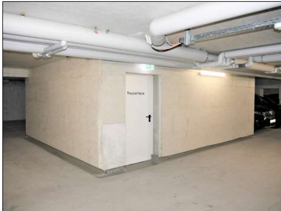
Tiefgarage mit Zugang zur Schleuse des Treppenhauses im Gebäudeteil Lindenstr. 28A
