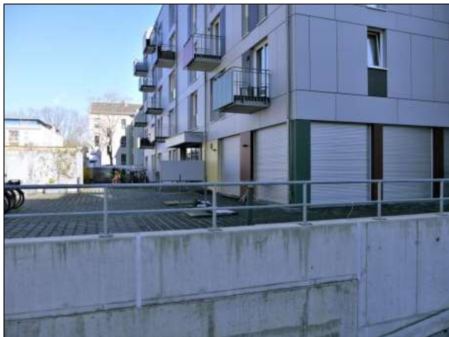
Blick über die Tiefgaragenrampe
