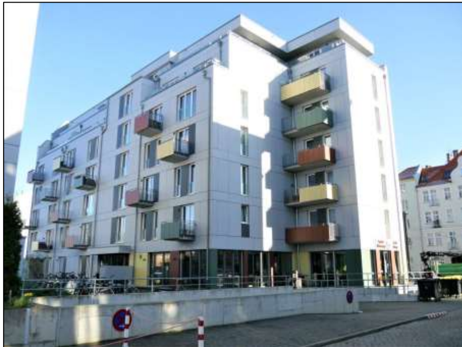
freie Giebelseite und rückwärtige Front der Gebäudeteile Lindenstr. 28 und 28A im Vordergrund
