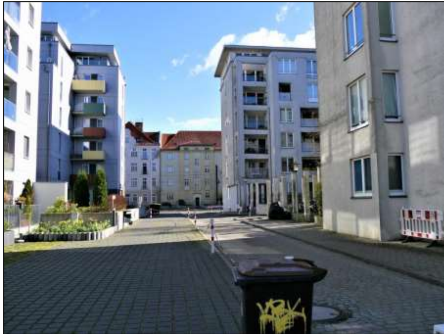
Blick auf die Durchwegung zwischen Spreeufer und Lindenstraße im Hintergrund mit links im Bild belegenen Gebäudeteilen Lindenstr. 28B und 28A sowie rechts im Bild belegener Bebauung auf dem süd-östlich angrenzenden Nachbargrundstück bzw. auf der nord-östlichen Straßenseite belegener Altbauung im Hintergrund
