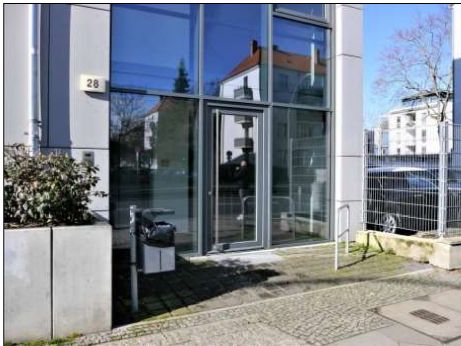
straßenseitige Front des Treppenhauseingangs des Gebäudeteils Lindenstr. 28
