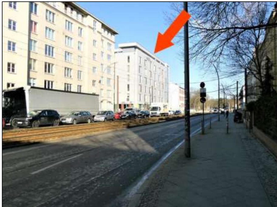
Blick über die Lindenstraße nach Nord-Westen mit Lage des Grundstücks Lindenstraße 28, 28A, 28B, 28C, 28D auf der süd-westlichen bzw. im Bild linken Straßenseite mit aufstehendem Gebäude Lindenstr. 28, 28A (Pfeil)
