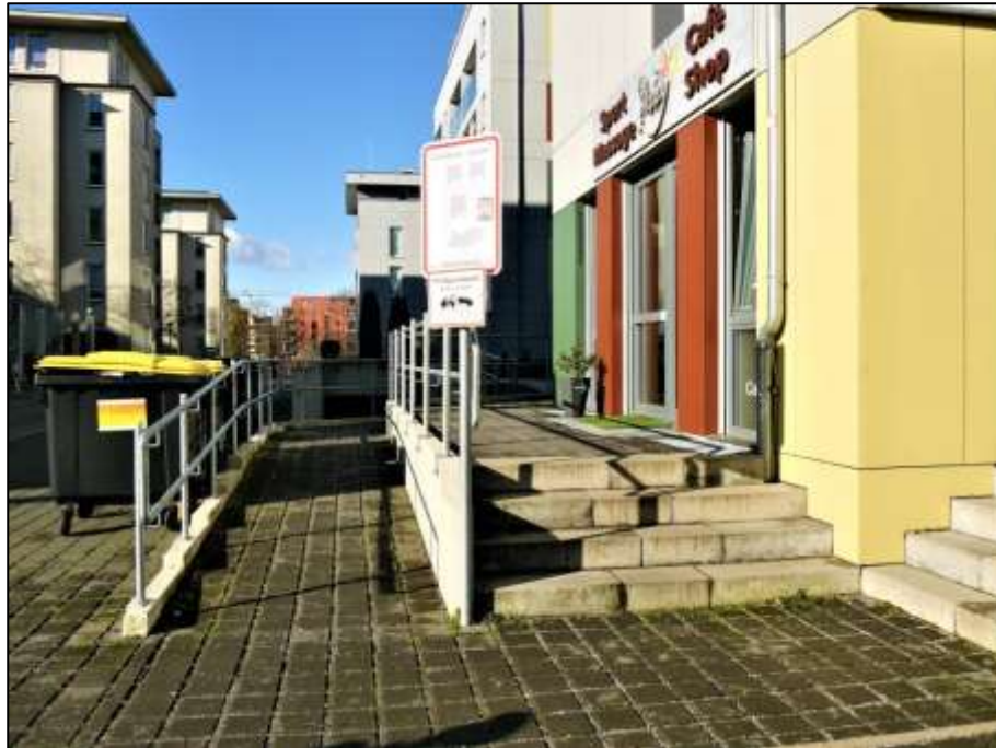
zum linken Bauwich orientierte Giebelseite des Gebäudeteils Lindenstr. 28A mit Teileigentum Nr. GE 116 im Erdgeschoss im Vordergrund nebst Differenzterasse und Rampe für einen barrierefreien Zugang u.a. des Teileigentums Nr. GE 116
