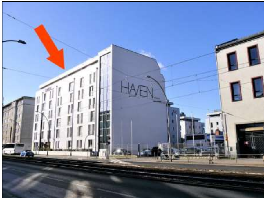
Blick über die Lindenstraße nach Süden mit Lage des Grundstücks Lindenstraße 28, 28A, 28B, 28C, 28D auf der süd-westlichen Straßenseite mit aufstehendem Gebäude Lindenstr. 28, 28A (Pfeil)
