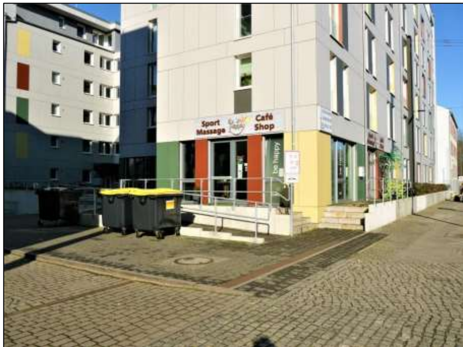
straßenseitige Front und zum linken Bauwich orientierte Giebelseite des Gebäudeteils Lindenstr. 28A im Vordergrund mit Teileigentum Nr. GE 116 im Erdgeschoss
