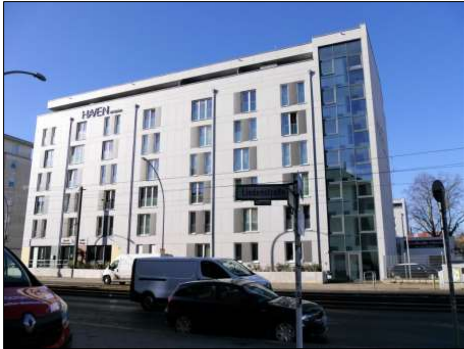
Blick über die Lindenstraße nach Süd-Westen mit Lage des Grundstücks Lindenstraße 28, 28A, 28B, 28C, 28D und straßenseitig aufstehendem Gebäude Lindenstr. 28, 28A
