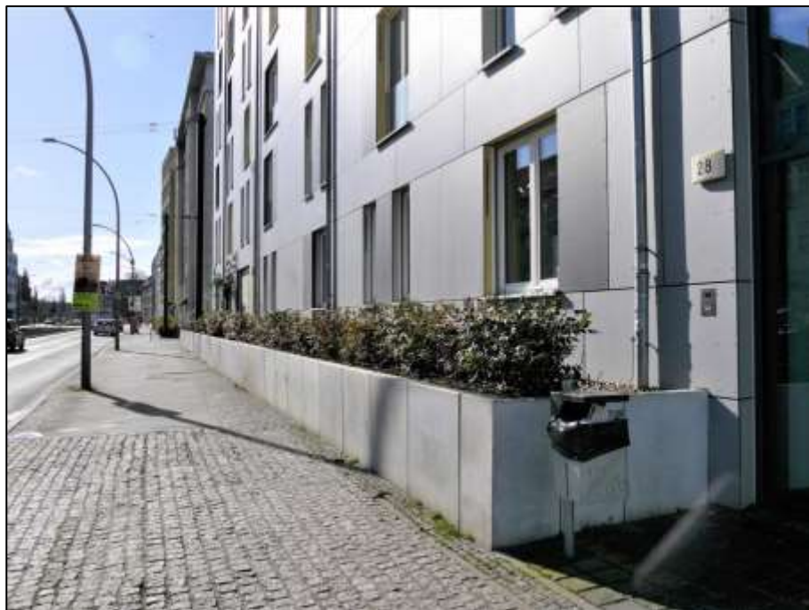
straßenseitige Front des Gebäudeteils Lindenstr. 28, 28A mit Hauseingang des Gebäudeteils Lindenstraße 28 im Vordergrund rechts
