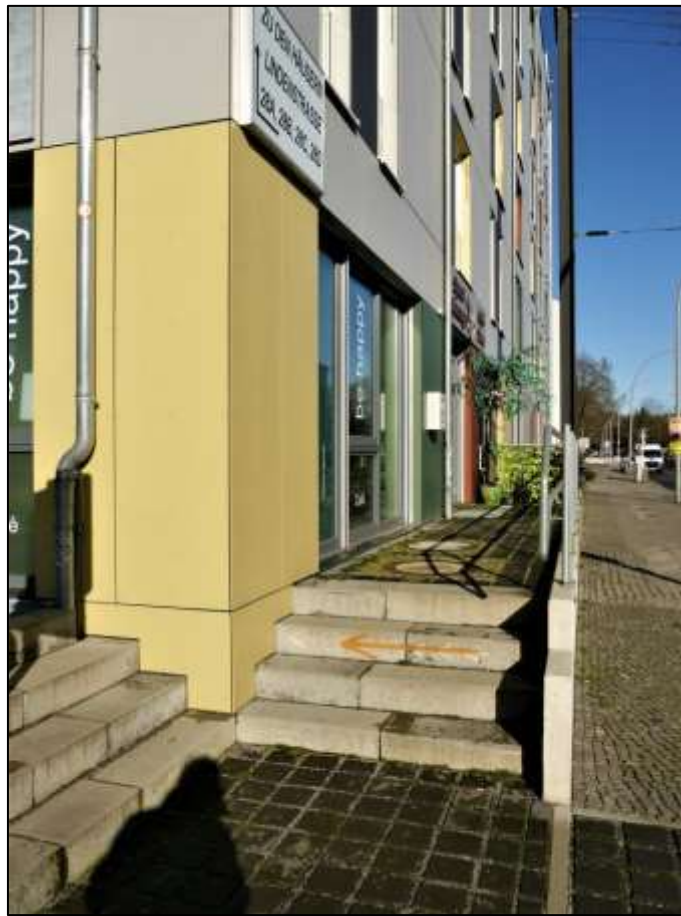
straßenseitige Front des Gebäudeteils Lindenstr. 28A mit Teileigentum Nr. GE 116 im Erdgeschoss im Vordergrund
