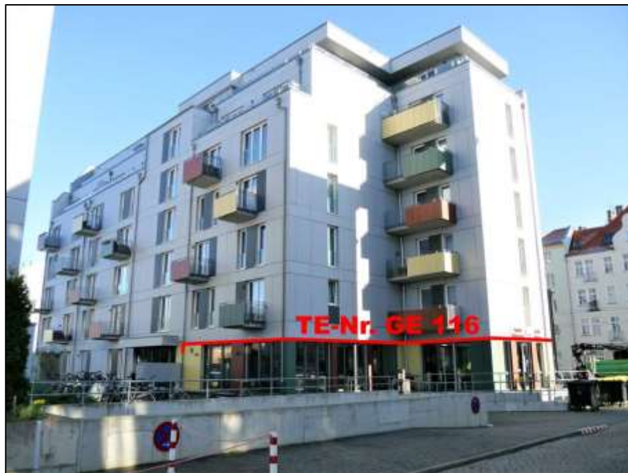
freie Giebelseite und rückwärtige Front des Gebäudeteils Lindenstr. 28A im Vordergrund mit Lage des Teileigentums Nr. GE 116 im Erdgeschoss und aufgezogenen Rollladenanlagen
