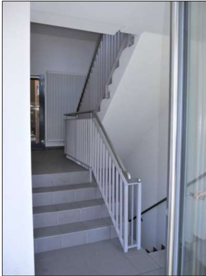
typischer Haus- eingangsbereich der Gebäudeteile auf dem Grund- stück
