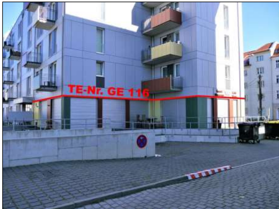
freie Giebelseite und rückwärtige Front des Gebäudeteils Lindenstr. 28A im Vordergrund mit Lage des Teileigentums Nr. GE 116 und geschlossenen Rollladenanlagen im Erdgeschoss
