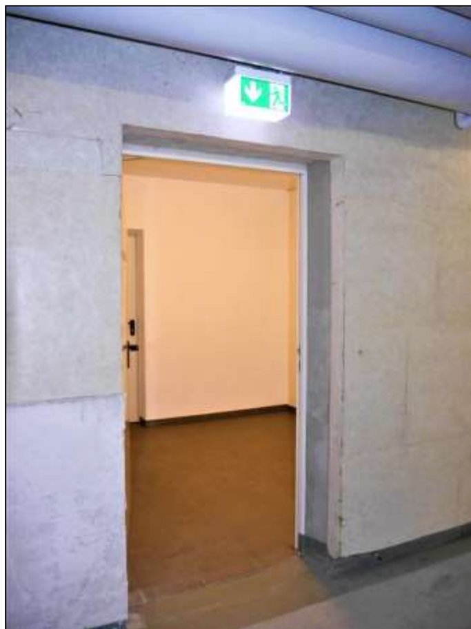
Zugang aus der Tiefgarage zur Schleuse des Treppenhauses im Gebäudeteil Lindenstr. 28A
