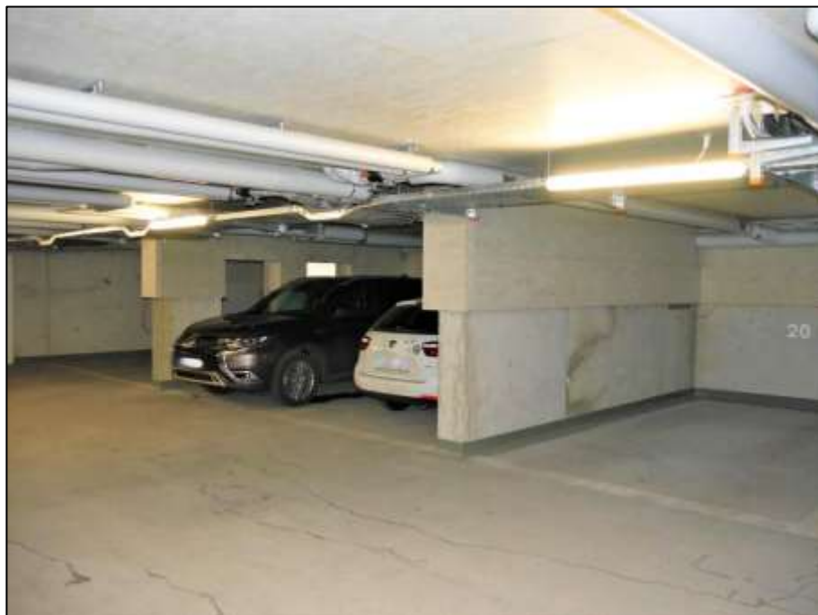
Stellplatzbereiche der Tiefgarage
