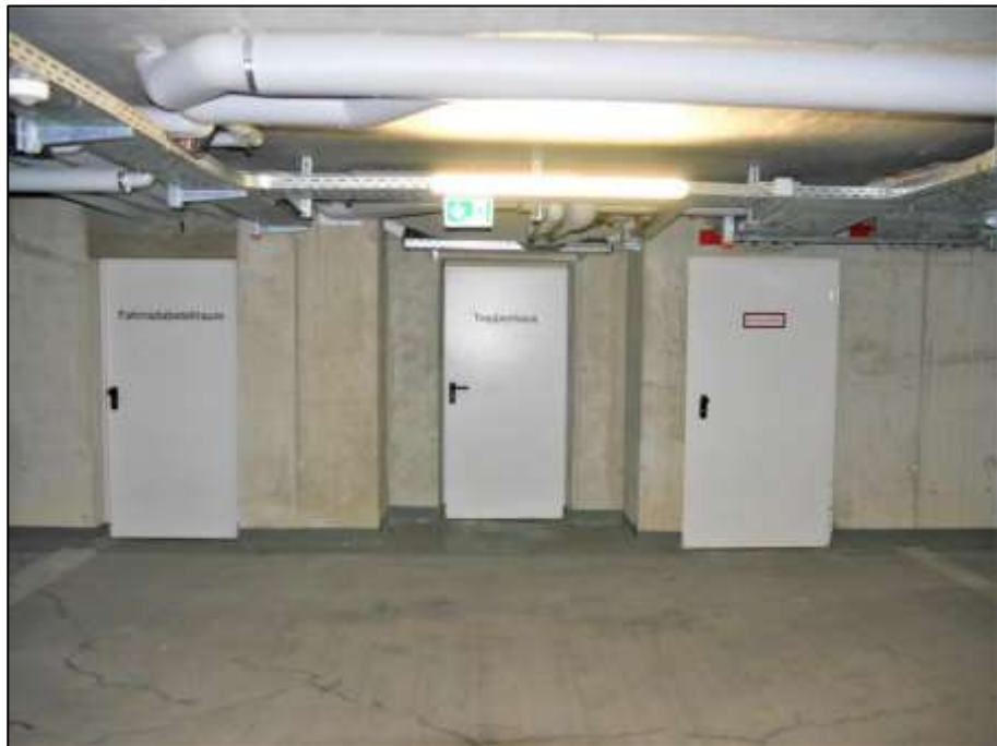
an die Tiefgarage anbindender Kellerbereich mit Zugang u.a. zum Treppenhaus des Gebäudeteils Lindenstr. 28
