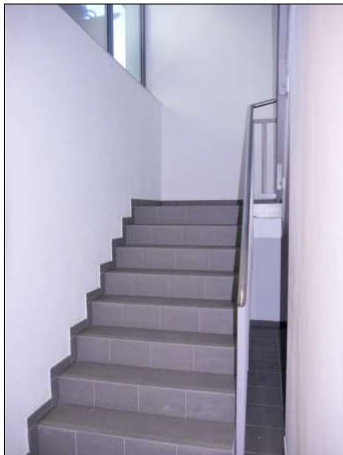
Treppenauf- gang aus der Kellerdiele zum Hauseingangs- bereich des Treppenhauses im Gebäudeteil Lindenstr. 28A
