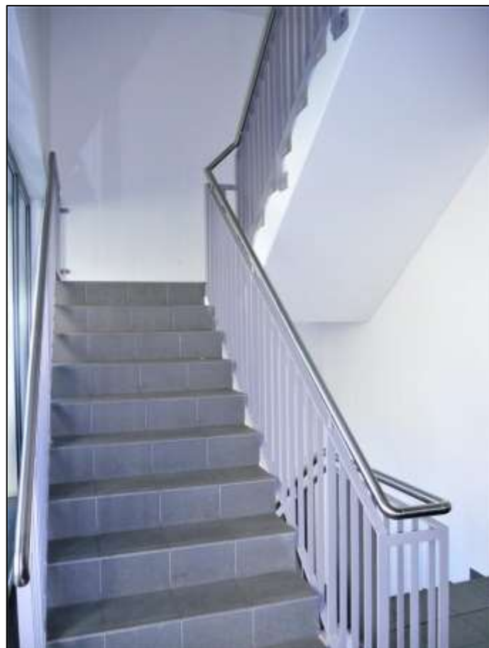
typischer Trepp- penhausauf- gang der Ge- bäudeteile auf dem Grund- stück
