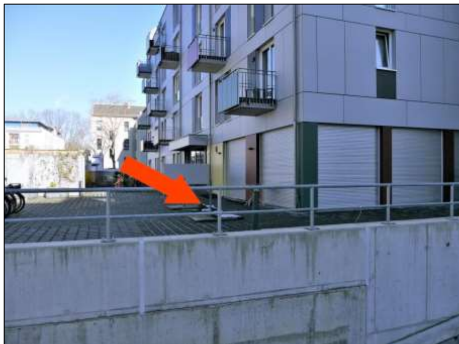
Blick über die Tiefgaragenrampe auf die dem Teileigentum Nr. GE 116 als dingliches Sondernutzungsrecht zugeschriebenen Terrassenfläche (Pfeil) vor der rückwärtigen Front des Gebäudeteils Lindenstr. 28A im Bereich des angrenzenden Teileigentums Nr. GE 116
