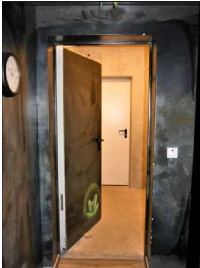
Zugang aus dem Flur im Untergeschoss des Teileigentums Nr. GE 116 in die Schleuse zur Tiefgarage
