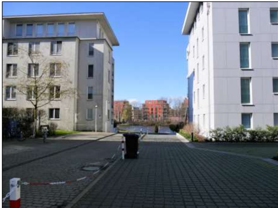
Blick auf die Durchwegung zum Spreeufer mit auf der süd-westlichen Uferseite belegenen Wohngebäuden (rot) im Hintergrund - rechts im Bild: Gebäudeteil Lindenstr. 28D
