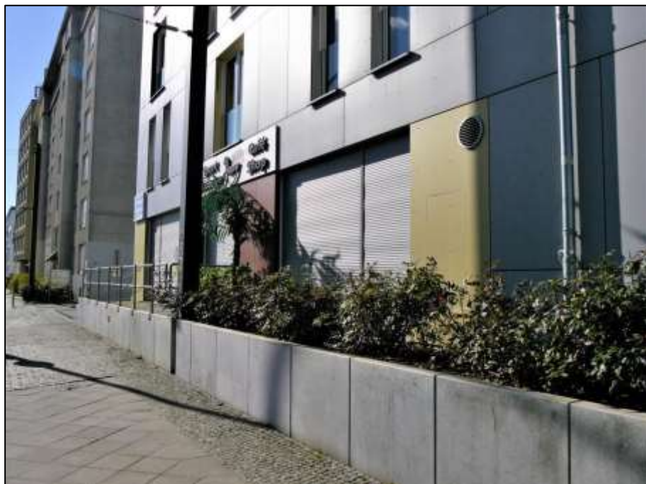
straßenseitige Front des Gebäudeteils Lindenstr. 28A im Bereich des Teileigentums Nr. GE 116
