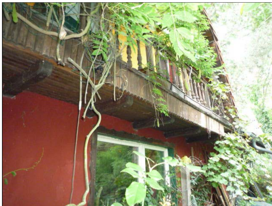
Giebelansicht mit Balkon
