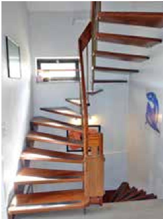
Treppe vom EG zum DG
