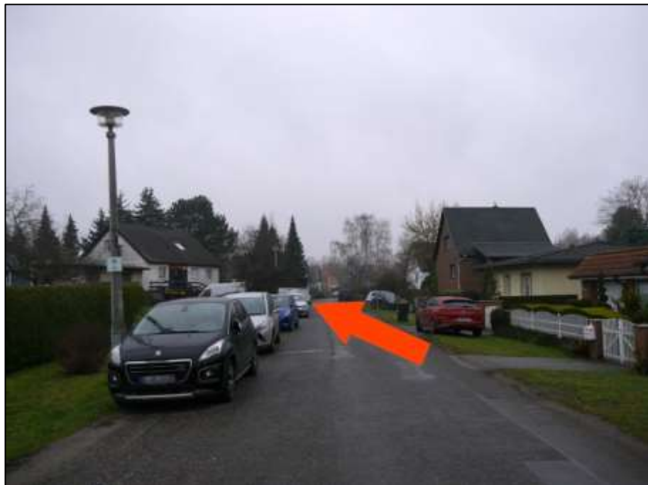
Blick in die Ludwig-Quidde-Straße nach Süd-Westen mit Lage des Grundstücks Ludwig-Quidde-Str. 24A auf der süd-östlichen bzw. im Bild linken Straßenseite (Pfeil)
