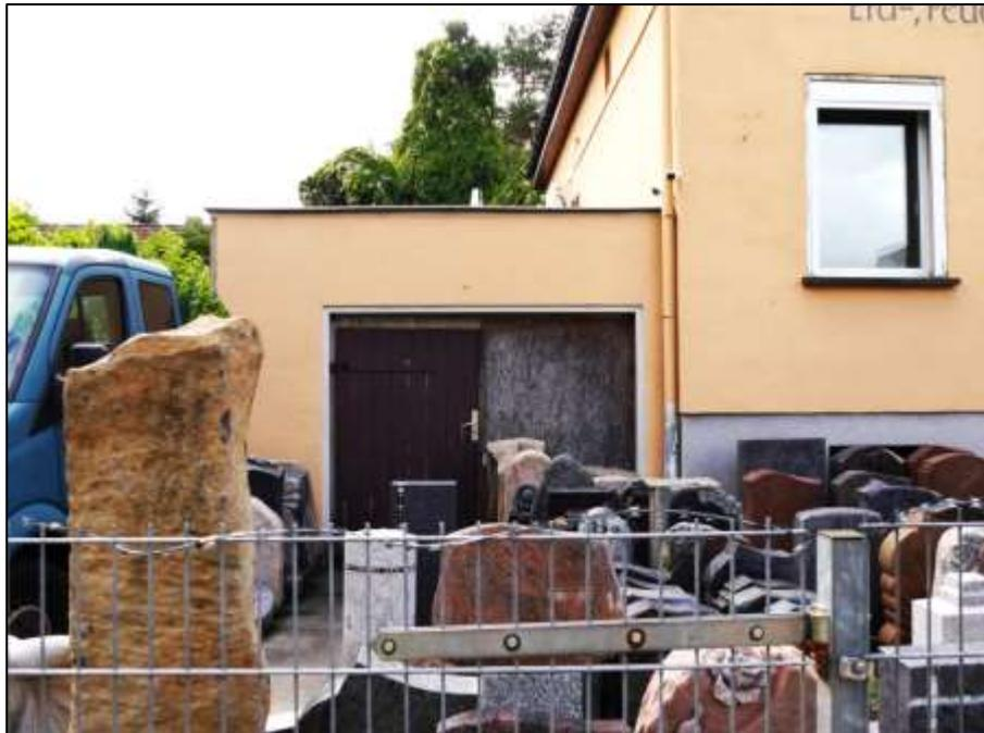
Garagen-Anbau an das Wohngebäude mit Nutzung nach Sachlage nicht als Garage, sondern vermtl. als Werkstatt- oder Lagerraum mit einfacher Brettholztür und OSB-Plattengefach anstelle eines Schwingflügeltors o.ä. in der Garageneinfahrt
