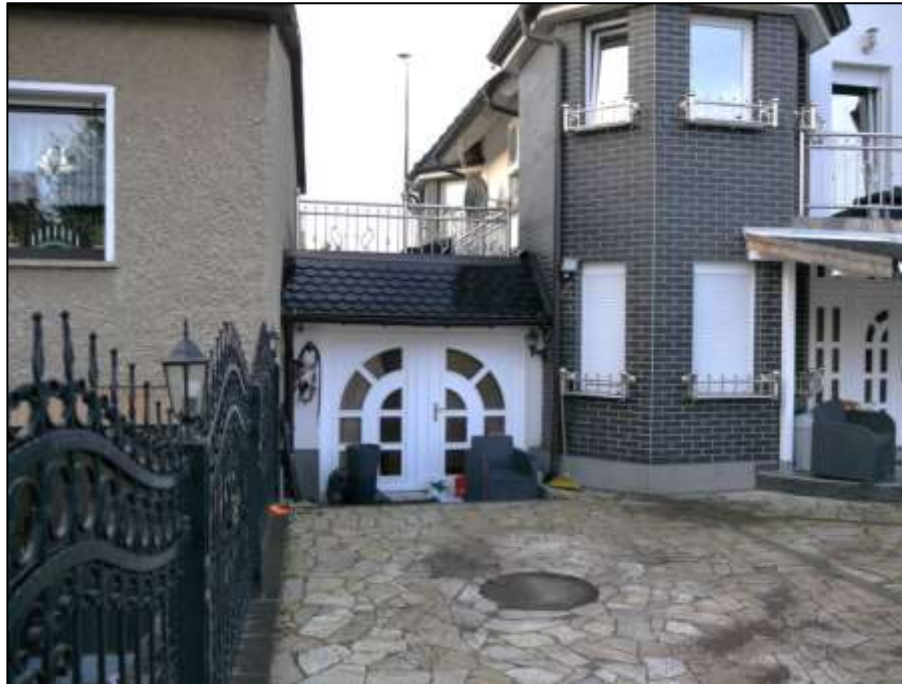
Blick über die straßenseitige Einfriedung respektive die Toranlage in der Einfriedung auf das Doppelflügeltor in dem 1-geschossigen Anbau an das Wohngebäude mit technischen Nebenräumen anstelle der ursprünglich genehmigten Grenzgarage
