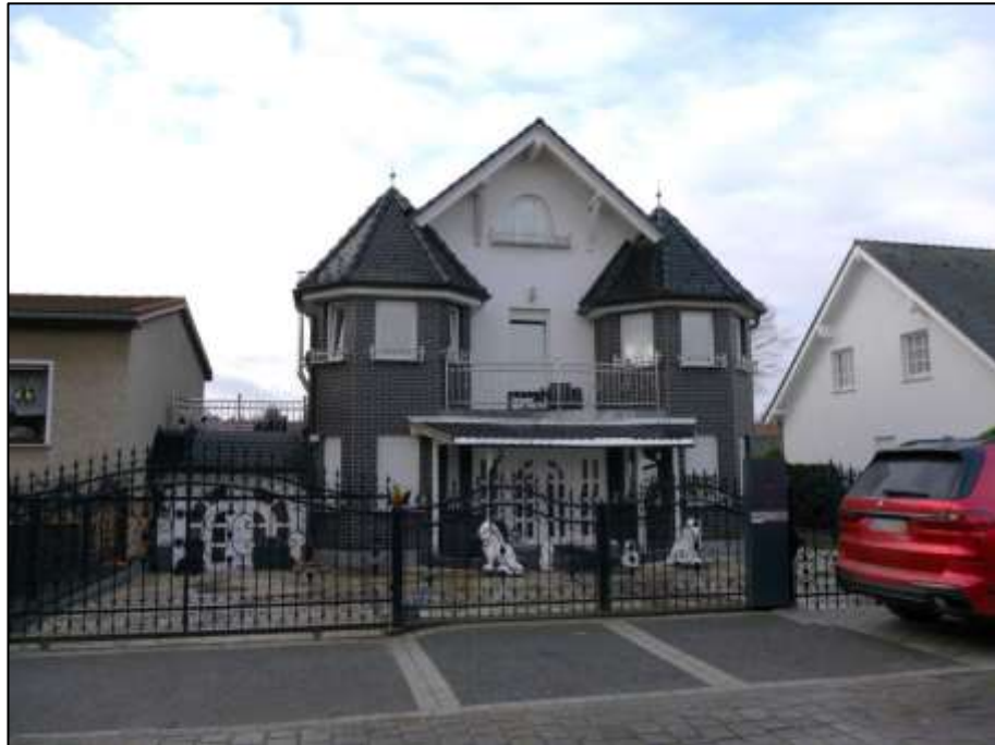
Blick aus dem Obersteiner Weg nach Süd-Westen auf die straßenseitige mit an den Gebäudestamm anbindenden 2½-geschossigen Ecktürmchen sowie 1-geschossiger Anbau im linken Bauwuch als ehemals vorgesehene Grenzgarage und nunmehr tatsächliche Erweiterung des Wohngebäudes
