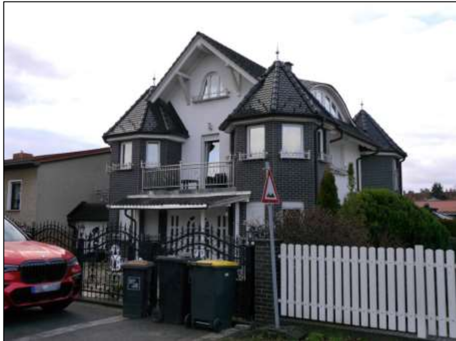
Blick aus dem Obersteiner Weg nach Süden auf die straßenseitige Giebelseite und die zum rechten Bauwich orientierte Traufseite des Einfamilienhauses mit Gebäudestamm und an dessen Ecken 2½-geschossig aufgehenden Ecktürmchen
