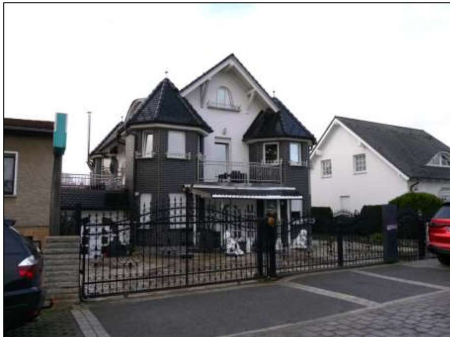
Blick aus dem Obersteiner Weg nach Westen auf die straßenseitige Giebelseite und die zum linken Bauwuch orientierte Traufseite des Einfamilienhauses mit Gebäudestamm und an dessen Ecken 2½-geschossig aufgehenden Ecktürmchen sowie 1-geschossiger Anbau
