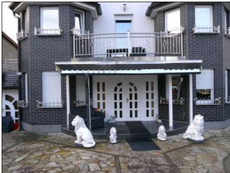
gedeckter straßenseitiger Hauseingang des Einfamilienhauses mit hoch aufgehender Podestschwelle vor der Hauseingangsdoppelflügeltür und über dem Hauseingangsbereich belegener Balkonterrasse mit Zugang aus der im Obergeschoss belegenen Diele
