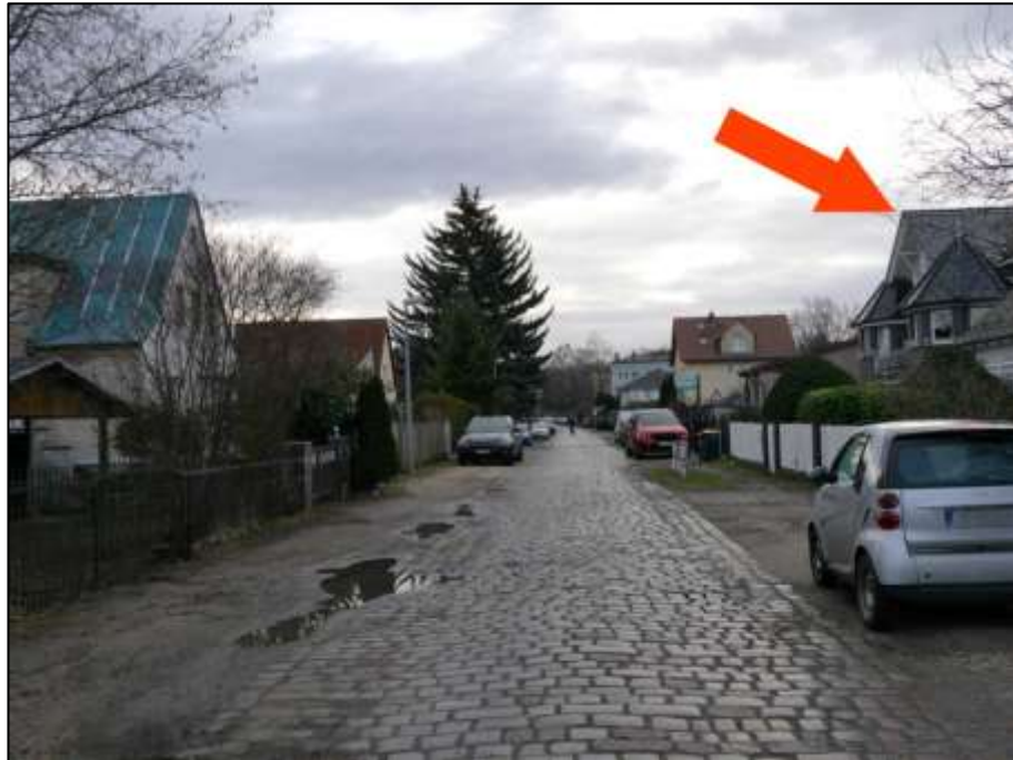
Blick in den Obersteiner Weg nach Süd-Osten mit Lage des auf dem Grundstück Obersteiner Weg 24 aufstehenden Einfamilienhauses auf der süd-westlichen bzw. im Bild rechten Straßenseite (Pfeil)
