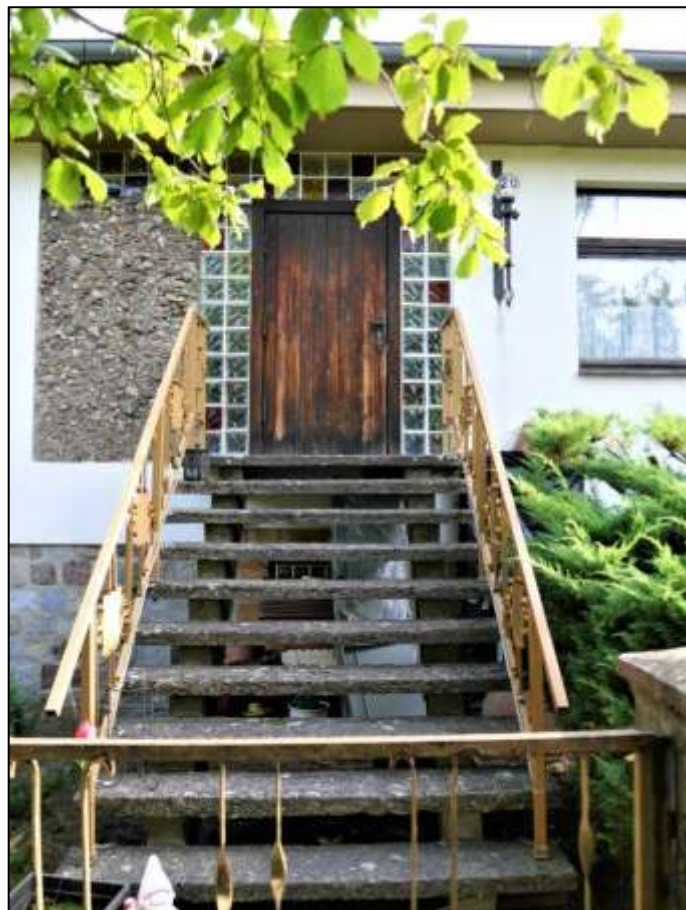
Blick über die Zugangspforte der Hauszuwegung in der straßenseitigen Grundstückseinfriedung des Grundstücks Heimfriedstraße 26 auf die Eingangstreppe mit anbindender Hauseingangstür des Wohngebäudes
