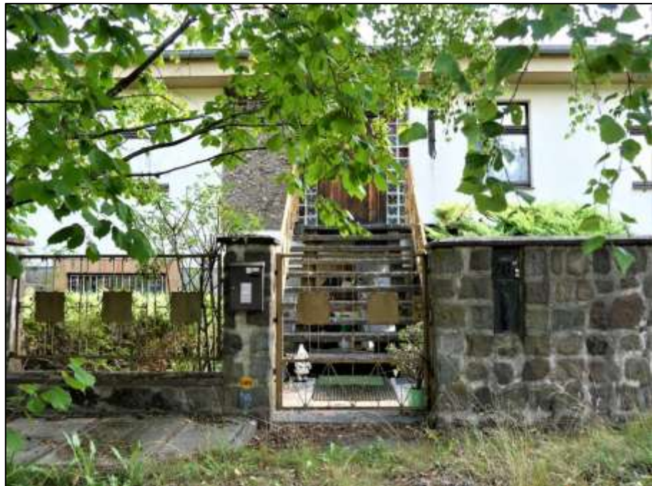
Blick aus der Heimfriedstraße nach Nord-Osten auf die straßenseitige Front des Grundstücks Heimfriedstraße 26 hinter dem Grünstreifen auf die Zugangspforte der Hauszuwegung in der Grundstückseinfriedung
