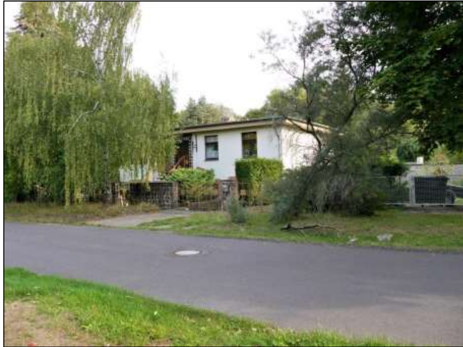
Blick über die Heimfriedstraße nach Norden auf das Grundstück Heimfriedstr. 26 mit straßenseitiger Grundstücks- und Wohnhausfront
