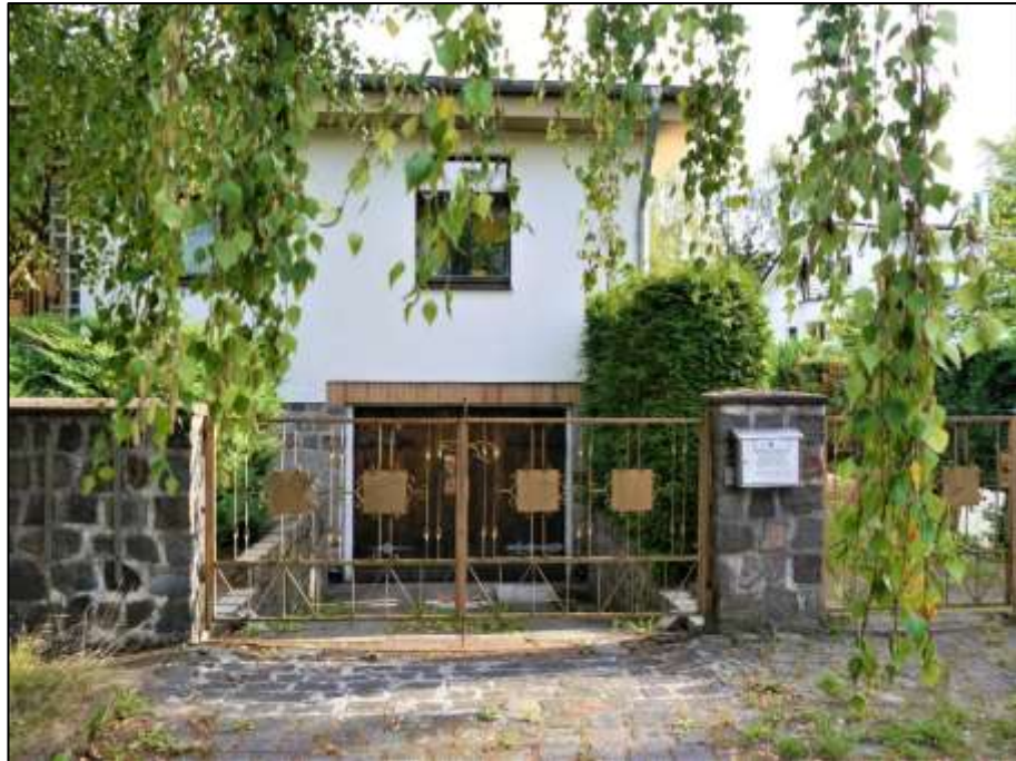
Blick aus der Heimfriedstraße nach Nord-Osten auf die straßenseitige Front des Grundstücks Heimfriedstraße 26 im Bereich der Kellergaragenzufahrt über den Grünstreifen im öffentlichen Straßenraum auf die Toranlage der Kellergaragenrampe in der Grundstückseinfriedung
