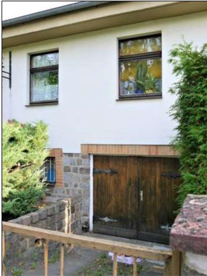
straßenseitige Wohnhausfront im Bereich der Kellergarage
