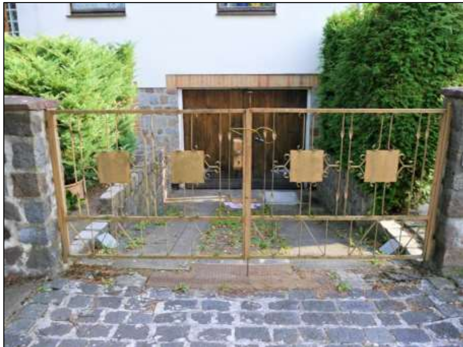
Blick auf die straßenseitige Front des Grundstücks Heimfriedstraße 26 aus dem Bereich der Kellergaragenzufahrt über die Toranlage der Kellergaragenrampe in der Grundstückseinfriedung auf die Kellergarage in dem Wohngebäude
