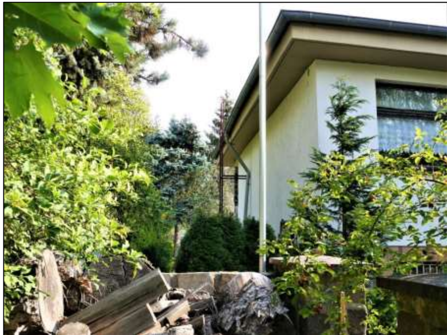
Blick über die Pforte zum Müllgefäßstellplatz in der straßenseitigen Einfriedung in den linken Bauwich des straßenseitigen Wohngebäudes mit festverwahrter Sautenleiter zum Flachdach - im Vordergrund Aluminium-Fahnenmast unmittelbar hinter dem Müllgefäßstellplatz
