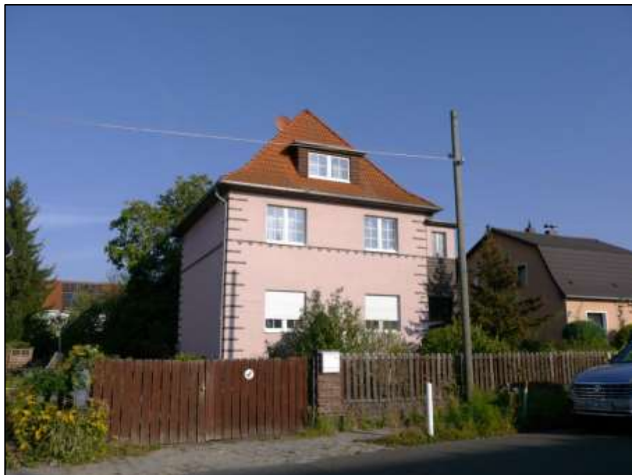
auf dem Grundstück Wischbergweg 11 aufstehendes Ein-/Zweifamilienhaus mit straßenseitiger Front und zum linken Bauwuch orientierter Gebäudefront
