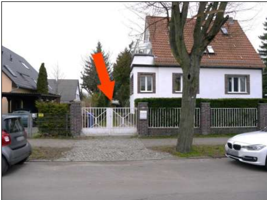
straßenseitige Front des Vordergrundstücks Feldtmannstr. 120 (Flurstück 275) mit Toranlage der Zufahrt zum Erschließungskorridor (GFL-Recht) zu dem in Hinterliegerlage belegenen Grundstück Feldtmannstr. 120 (Flurstück 276) mit aufstehender Bebauung (Pfeil)
