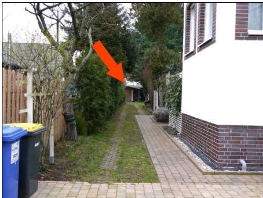
Blick über die straßenseitige Toranlage in den mit einem GFL-Recht belasteten Erschließungskorridor auf das Hinterliegergrundstück Feldtmannstr. 120 (Flst. 276) mit aufstehender Bebauung (Pfeil)
