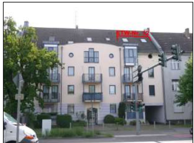
Gebäudefront mit ETW-Nr. 12 im 2.DG
