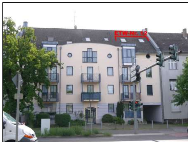
Gebäudefront mit ETW-Nr. 12 im 2.DG
