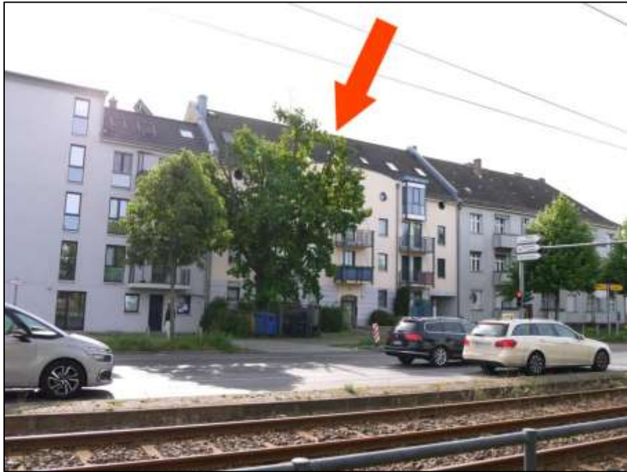
Blick über Pasewalker Straße nach Süd-Osten mit Lage des Grundstück Pasewalker Str. 99 auf der östlichen Straßenseite mit Lage der ETW-Nr. 12 im 2. Dachgeschoss (Pfeil)
