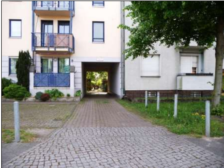
Blick über den als Feuerwehraufstellfläche befestigten Vorgartenstreifen auf die straßenseitige Front des auf dem Grundstück Pasewalker Str. 99 aufstehenden Gebäudes mit Gebäudedurchfahrt zum Hof des Anwesens
