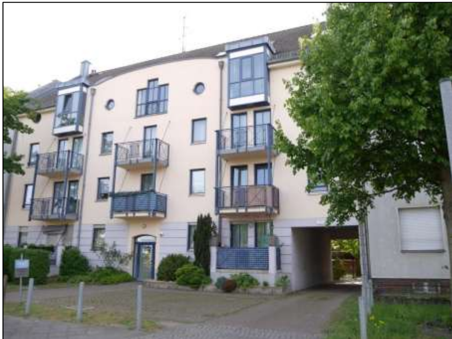
Blick aus der Pasewalker Straße nach Nord-Osten mit auf dem Grundstück Pasewalker Str. 99 aufstehenden Wohngebäude sowie Gebäudedurchfahrt zum Hof und straßenseitiger Hauseingang zum Treppenhaus
