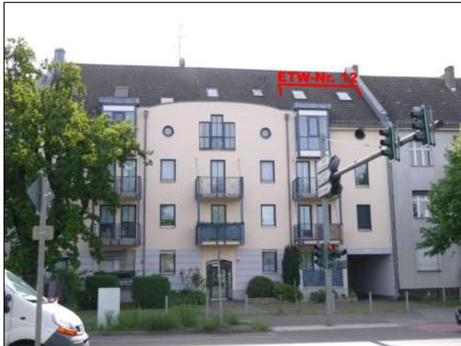
Blick über Pasewalker Straße nach Osten mit Lage des Grundstück Pasewalker Str. 99 auf der östlichen Straßenseite mit Lage der ETW-Nr. 12 im 2. Dachgeschoss
