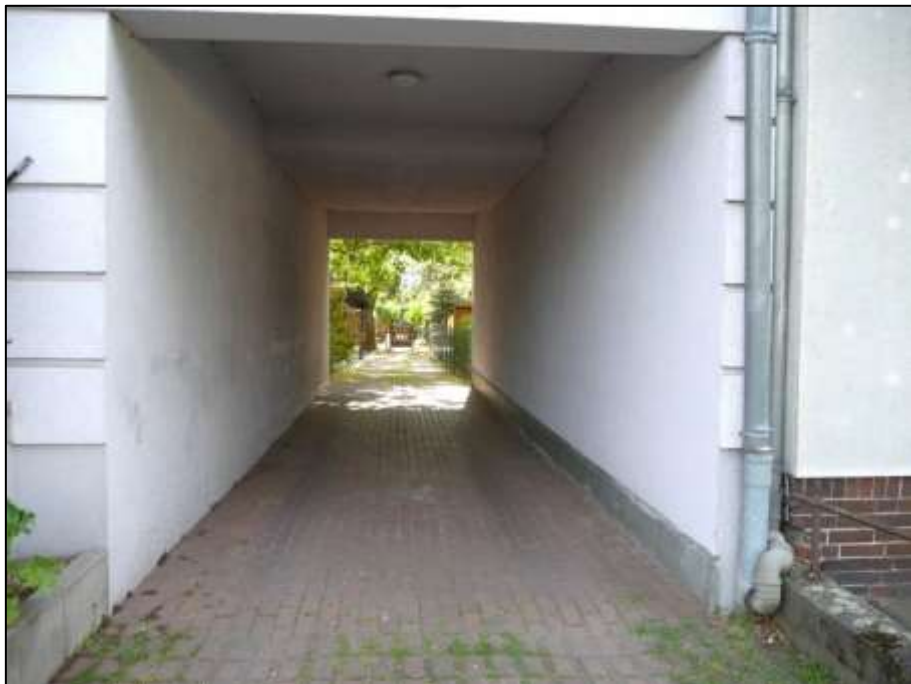
Gebäudedurchfahrt zum Hof des Anwesens mit dort u.a. belegenen PKW-Stellplatzanlage
