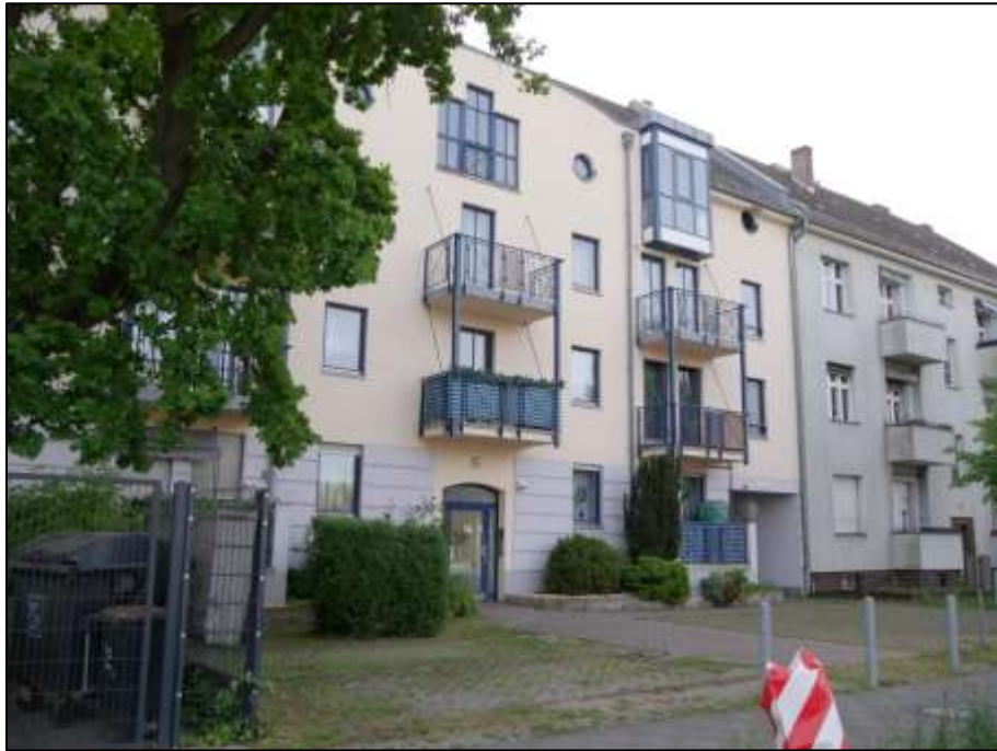
Blick aus der Pasewalker Straße nach Süd-Osten mit auf dem Grundstück Pasewalker Str. 99 aufstehenden Wohngebäude
