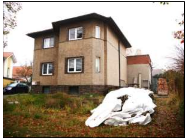
Straßenfront und rechte Giebelseite m. Anbau
