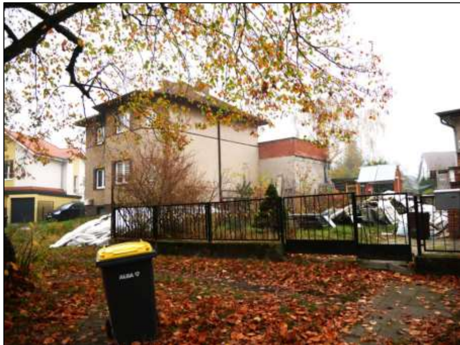
Blick aus dem Straßenraum nach Süden auf die straßenseitige Front und die zum rechten Bauwich orientierte Giebelseite des auf dem Grundstück Urbacher Str. 28 aufstehenden Zweifamilienhauses mit rückwärtig 1-geschossigem Anbau
