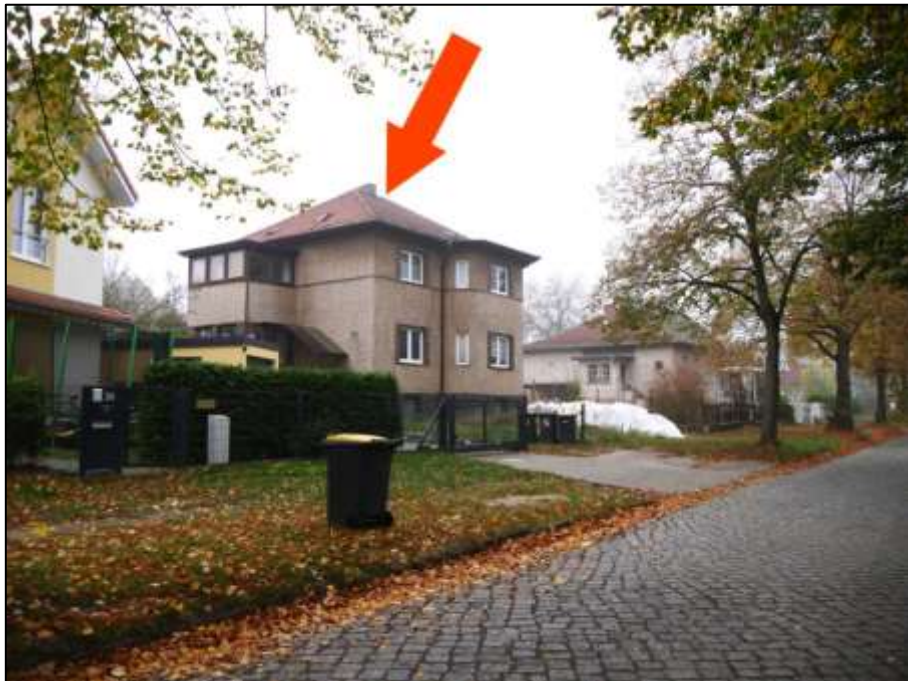
Blick aus der Urbacher Straße nach Nord-Westen mit Lage des Grundstücks Urbacher Str. 28 mit aufstehendem Zweifamilienhaus (Pfeil) auf der süd-westlichen Straßenseite
