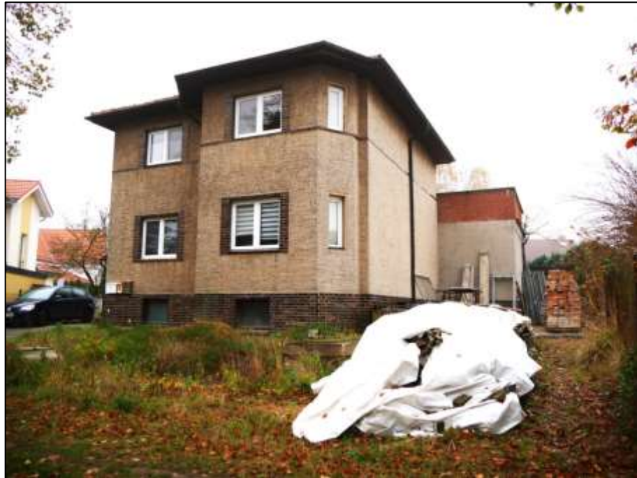
straßenseitige Front und zum rechten Bauwich orientierte Giebelseite des auf dem Grundstück Urbacher Str. 28 aufstehenden Zweifamilienhauses mit rückwärtig 1-geschossigem Anbau
