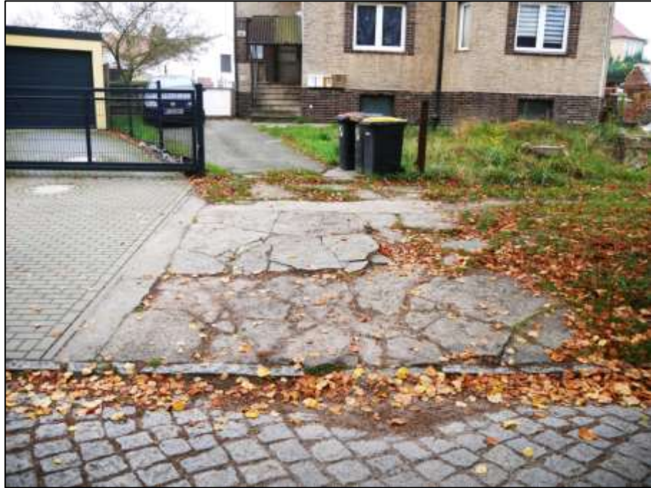
Gehweg- bzw. Grünstreifenüberfahrt von dem befestigten Fahrdamm auf das Grundstück Urbacher Str. 28
