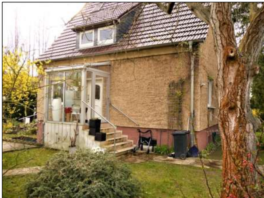
zur Schillerstraße orientierte Hauseingangsfront mit Windfang-Vorbau des auf dem Eckgrundstück Straße 18 Nr. 9 belegenen Einfamilienhauses nebst zur Straße 18 orientierter Giebelseite rechts im Bild
