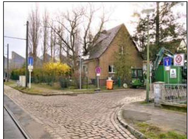
Eckgrundstück Straße 18 Nr. 9 mit EFH
