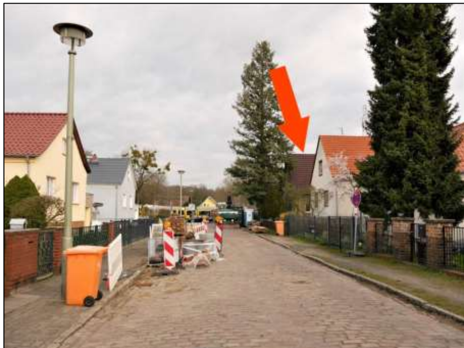
Blick in die Straße 18 nach Norden mit Lage des Grundstücks Straße 18 Nr. 9 auf der östlichen bzw. im Bild rechten Straßenseite mit aufstehendem Einfamilienhaus (Pfeil)
