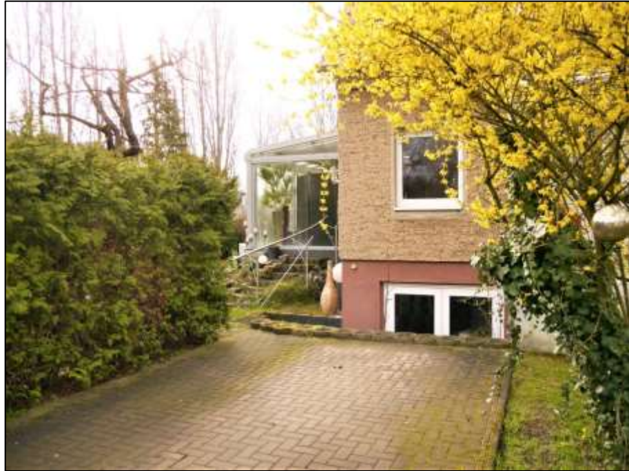
Blick aus der Schillerstraße über die Toranlage auf den auf dem Eckgrundstück Straße 18 Nr. 9 belegenen ungedeckten PKW-Stellplatz und die dahinter belegene ehemalige Kellergarage mit nunmehr vorhandenem Fenster hinter einem Lichtgraben sowie den Wintergarten vor der gartenseitigen Front des Einfamilienhauses
