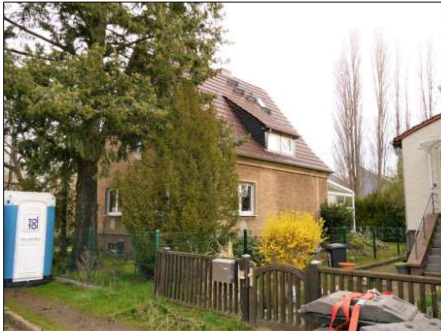
zur Straße 18 orientierte Giebelseite sowie zum rechten Bauwich orientierte Gebäudefront mit anbindendem Wintergarten im Hintergrund
