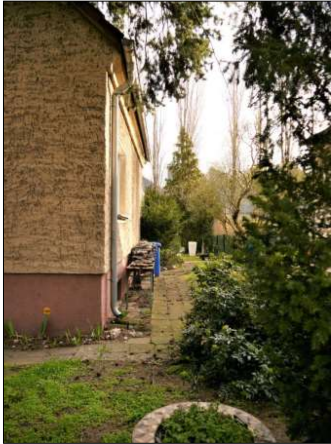
zur Straße 18 orientierte Giebelseite des auf dem Grundstück Straße 18 Nr. 9 aufstehenden Einfamilienhauses sowie zum rechten Bauwich orientierte Gebäudefront
