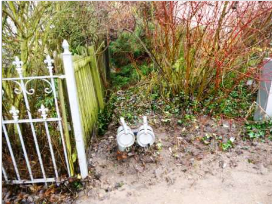
Absaugrohre mit Perrotkupplung der Fäkalienammelgruben auf dem Einfamilienhausgrundstück Karlshöhe 12 (Flurstück 24)
