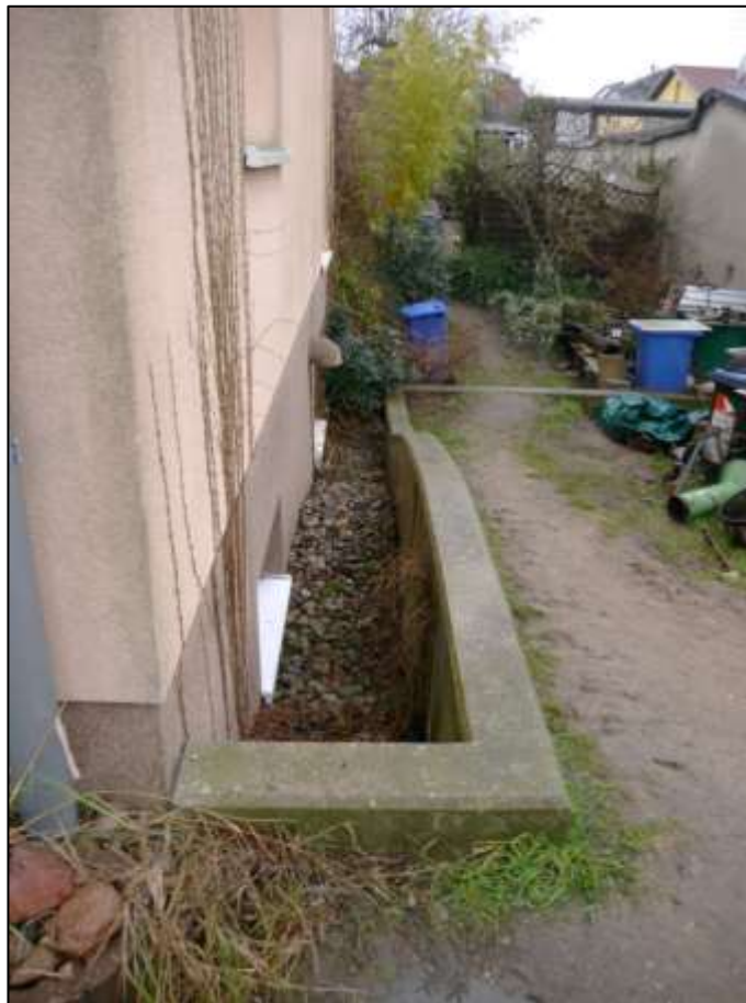
offener Kellerlichtschacht als sogen. Lichtgraben für die im Kellergeschoss in der nord-westlichen Giebelseite belegenen Räume
