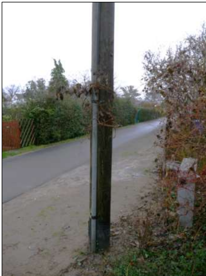
Holzmast der Strom-Freileitung im Bereich der Grundstücksmaske (Flurstück 23) mit Kabelkanal zum erdverlegten Stromanschluss des Einfamilienhausgrundstücks (Flurstück 24)
