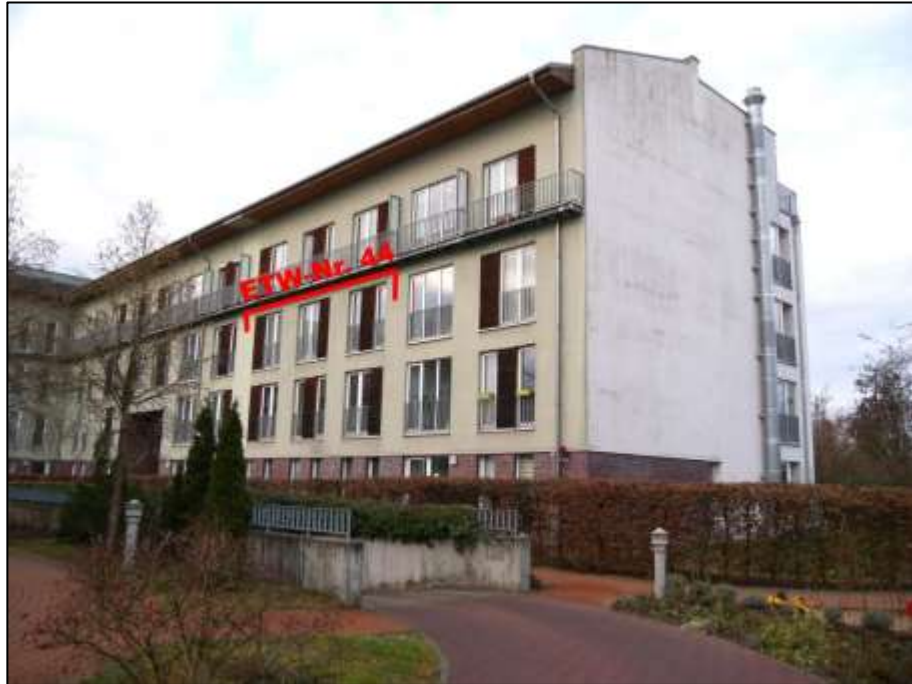
Tiefgaragenzufahrt mit anbindender Rampe sowie Gebäudeteil Aubertstr. 19 mit freier Giebelseite und Lage der ETW-Nr. 44 im 2.OG
