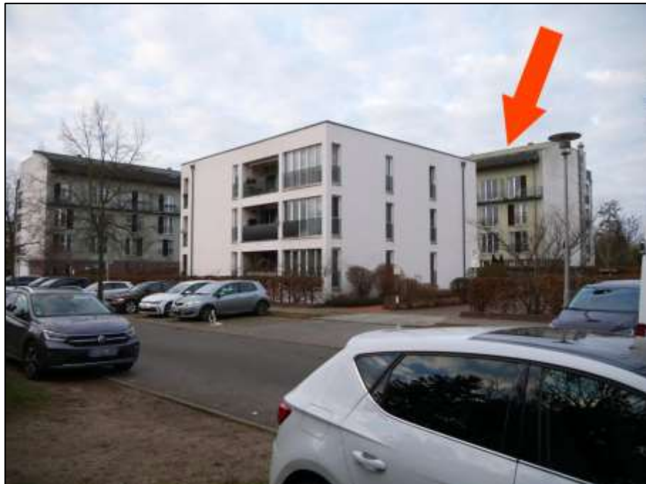
Blick aus der Aubertstraße nach Westen mit Lage des Gebäudeteils Aubertstr. 19 (Pfeil)
