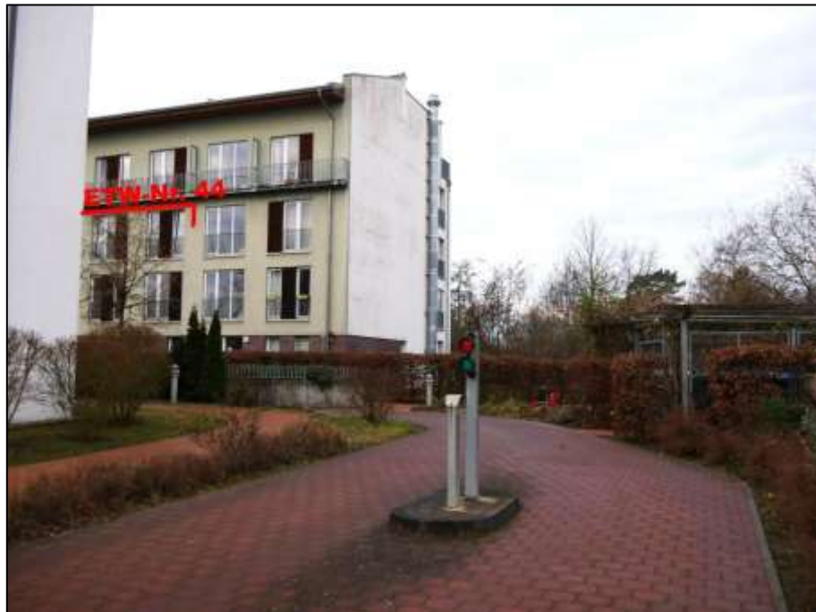
Tiefgaragenzufahrt mit Ampelregelung der Ein- und Ausfahrt sowie Gebäudeteil Aubertstr. 19 mit freier Giebelseite im Hintergrund und Lage der ETW-Nr. 44 im 2.OG
