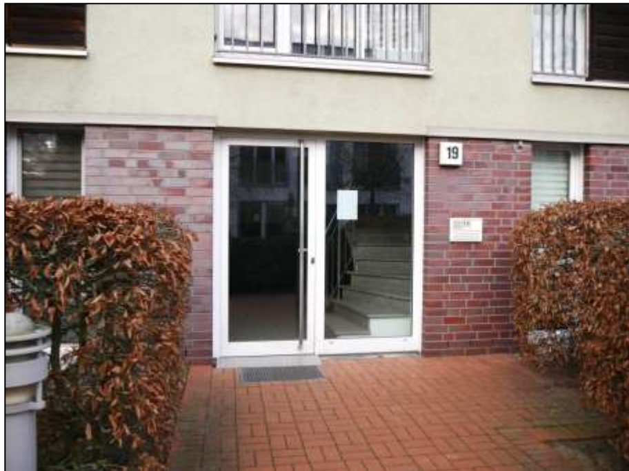
Hauseingangstür zum Treppenhaus des Gebäudeteils Aubertstr. 19
