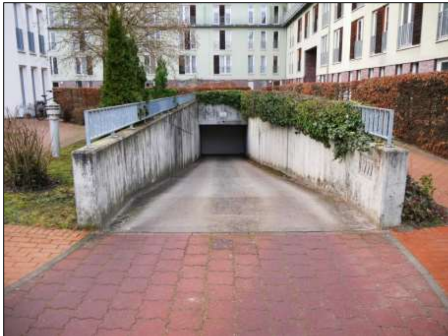
Tiefgaragenrampe mit Ein- und Ausfahrt
