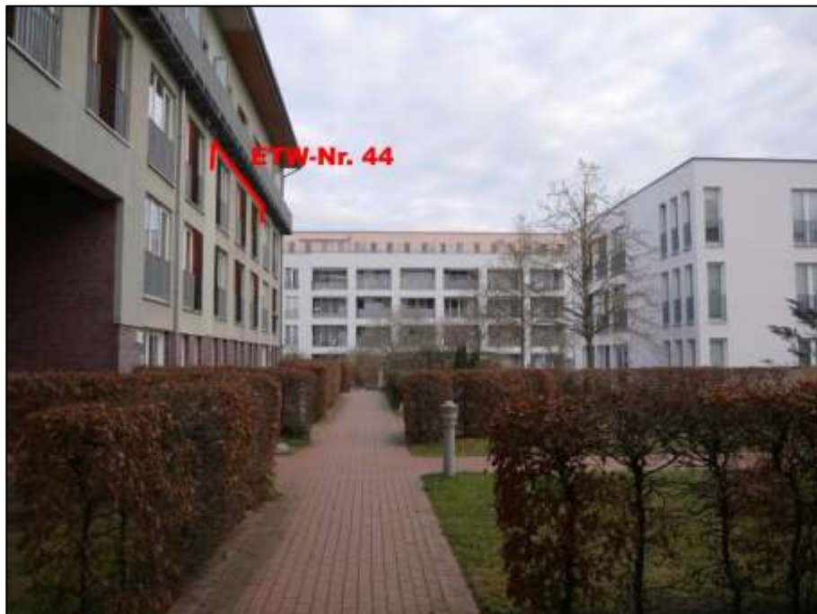
Blick aus dem Bereich des süd-westlichen Schenkels auf die Front des nord-westlichen Schenkels des L-förmigen Zeilentraktes mit Gebäudedurchwegung im Vordergrund und Gebäudeteil Aubertstr. 19 als nord-östliche Kopfseite im Hintergrund mit ETW-Nr. 44 im 2.OG
