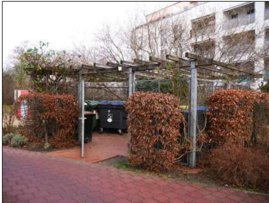
eingehauste Müllgefäß-Stellplatzanlage vor der nord-östlichen Grundstücksgrenze
