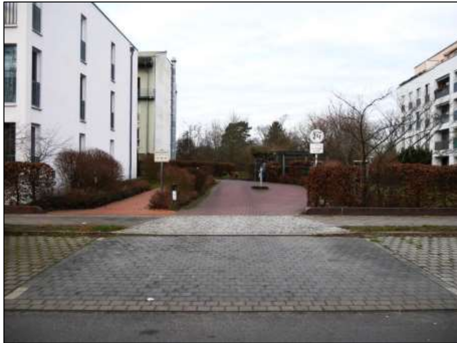
Blick aus dem öffentlichen Straßenraum nach Westen mit Tiefgaragenzufahrt sowie Solitärgebäude Aubertstr. 21 links im Vordergrund und Gebäudeteil Aubertstr. 19 mit freier Giebelseite links im Hintergrund
