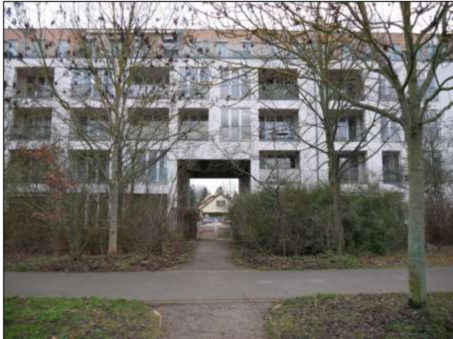
Blick aus der hinter dem Grundstück belegenen öffentlichen Parkanlage auf die u.a. öffentliche Gebäudedurchwegung im Gebäudeteil Aubertstr. 17 auf die nord-westliche Gebäudefront des L-förmigen Zeilentraktes
