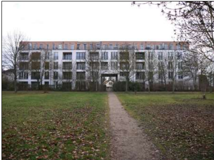
Blick aus der hinter dem Grundstück belegenen öffentlichen Parkanlage auf die nord-westliche Gebäudefront des L-förmigen Zeilentraktes u.a. mit privater und öffentlicher Gebäudedurchwegung im Gebäudeteil Aubertstraße 17
