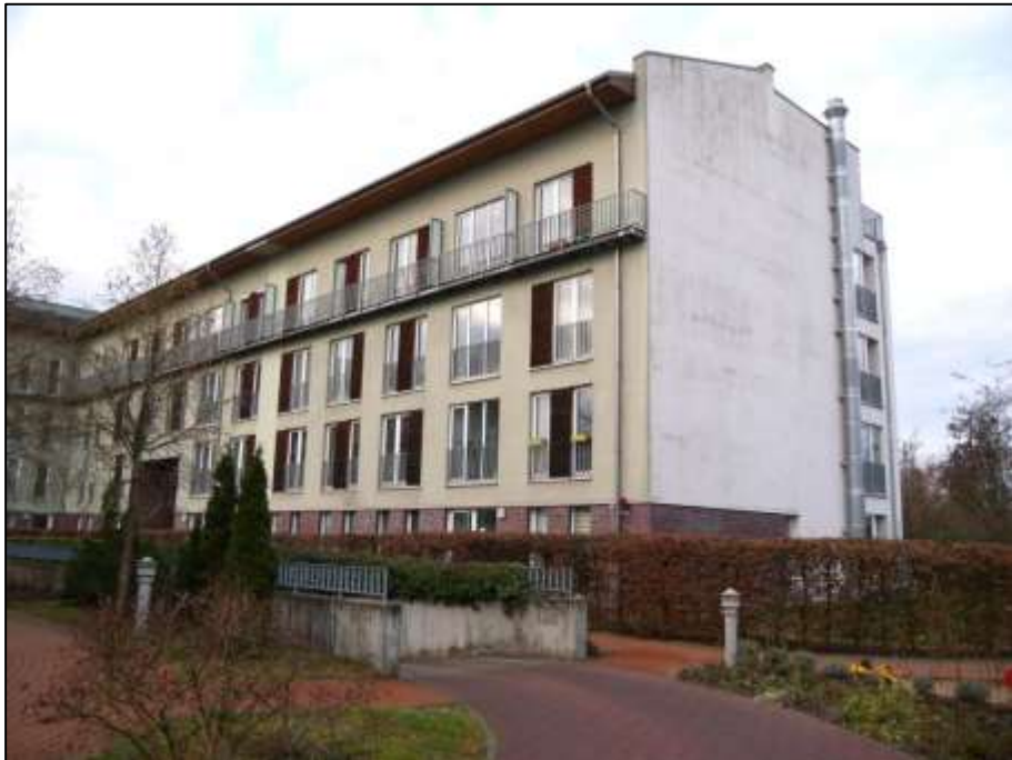
Tiefgaragenzufahrt mit anbindender Rampe sowie nord-westliche Giebelseite des L-förmigen Zeilentraktes im Bereich des Gebäudeteils Aubertstr. 19 im Hintergrund
