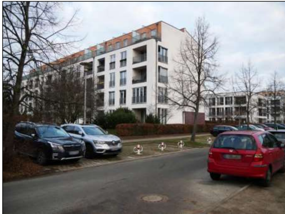
Blick aus der Aubertstraße von Süden auf das Grundstück Aubertstraße 11, 13, 15, 17, 19, 21 (Flurstücke 365, 366) auf der nord-westlichen Straßenseite
