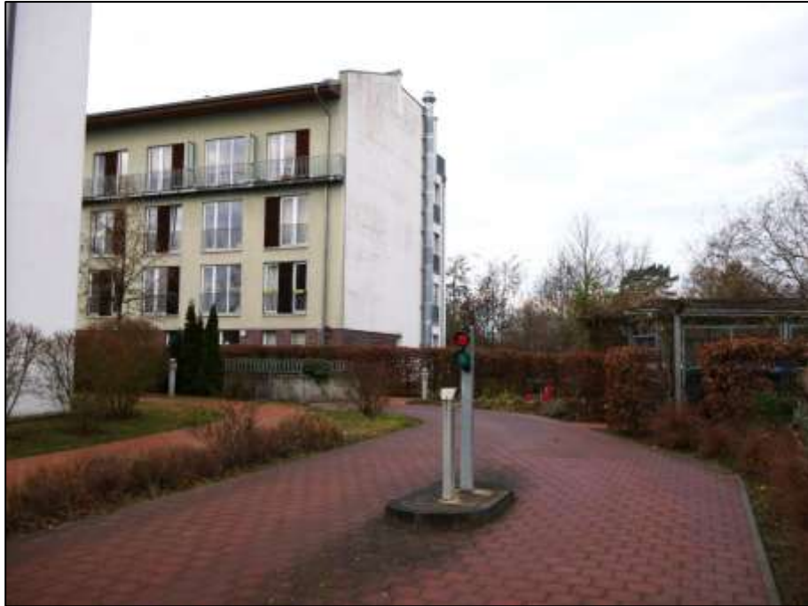
Tiefgaragenzufahrt mit Ampelregelung der Ein- und Ausfahrt im Vordergrund sowie nord-westliche Giebelseite des L-förmigen Zeilentraktes im Bereich des Gebäudeteils Aubertstr. 19 im Hintergrund
