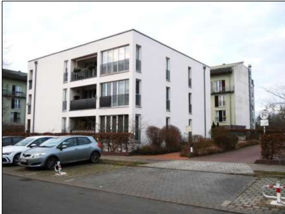
Blick aus dem öffentlichen Straßenraum von Osten mit im Vordergrund belegenem Solitärgebäude Auberstr. 21 und davor im rechten Bauwich des Gebäudes belegener Tiefgaragenzufahrt rechts im Bild sowie im Hintergrund belegenem Gebäudeteil Aubertstr. 19 mit freier nord-östlicher Giebelseite des L-förmigen Zeilentraktes
