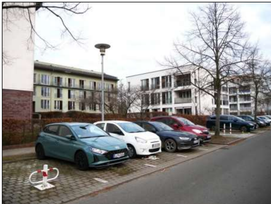
Blick aus der Aubertstraße von Süden auf das Grundstück Aubertstraße 11, 13, 15, 17, 19, 21 (Flurstücke 365, 366) auf der nord-westlichen Straßenseite mit ungedeckten Parktaschen-Stellplätzen auf dem hier betroffenen Grundstück mit Anfahrt aus dem öffentl. Straßenraum
