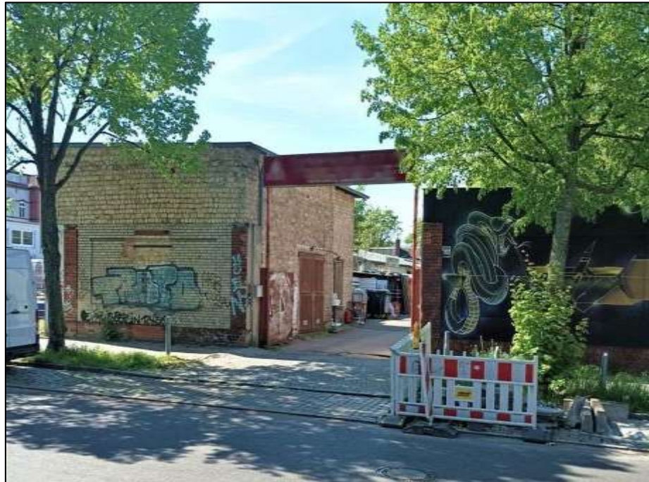
Blick aus dem Straßenraum der Streustraße auf die Einfahrt über das Vordergrundstück Streustr. 103 (Flurstück 278) zu dem in Hinterliegerlage belegnem Grundstück Streustr. 103 (Flurstück 276)
