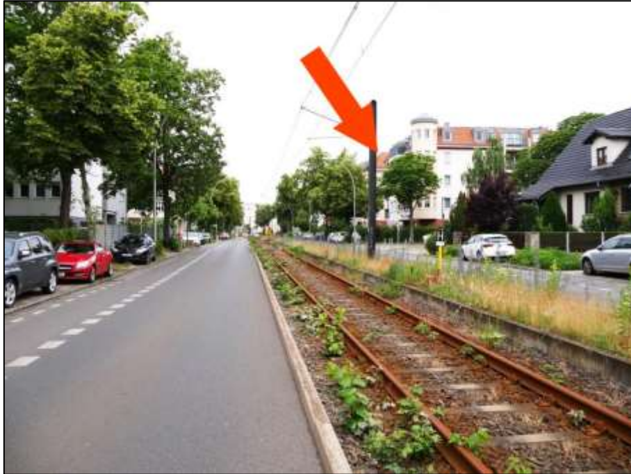
Blick in die Friedrich-Engels-Straße nach Nord-Westen mit Lage des auf dem Grundstück Friedrich-Engels-Str. 22 auf der nord-östlichen bzw. im Bild rechten Straßenseite aufstehenden Wohngebäudes (Pfeil)
