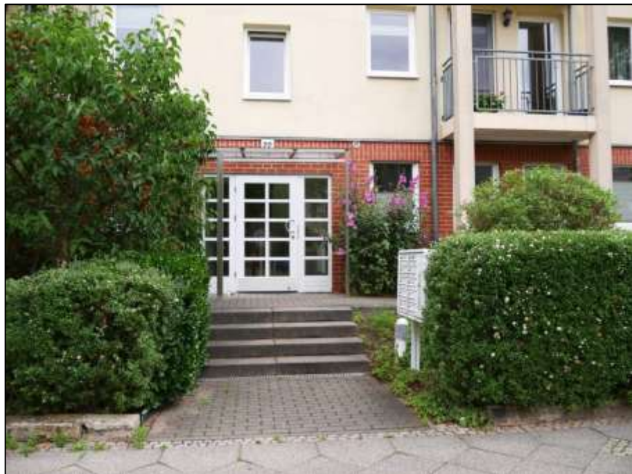
Hauszuwegung mit Differenztreppe zu der im Hochparterre belegenen Hauseingangstür des Treppenhauses
