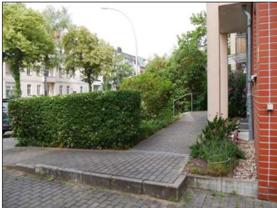
Blick aus dem rechten Bauwich des auf dem Grundstück Friedrich-Engels-Str. 22 aufstehenden Wohngebäudes auf den Vorgartenbereich mit aufgehender Rampe aus dem Straßenraum zur Hauseingangspodestfläche vor dem Treppenhaus
