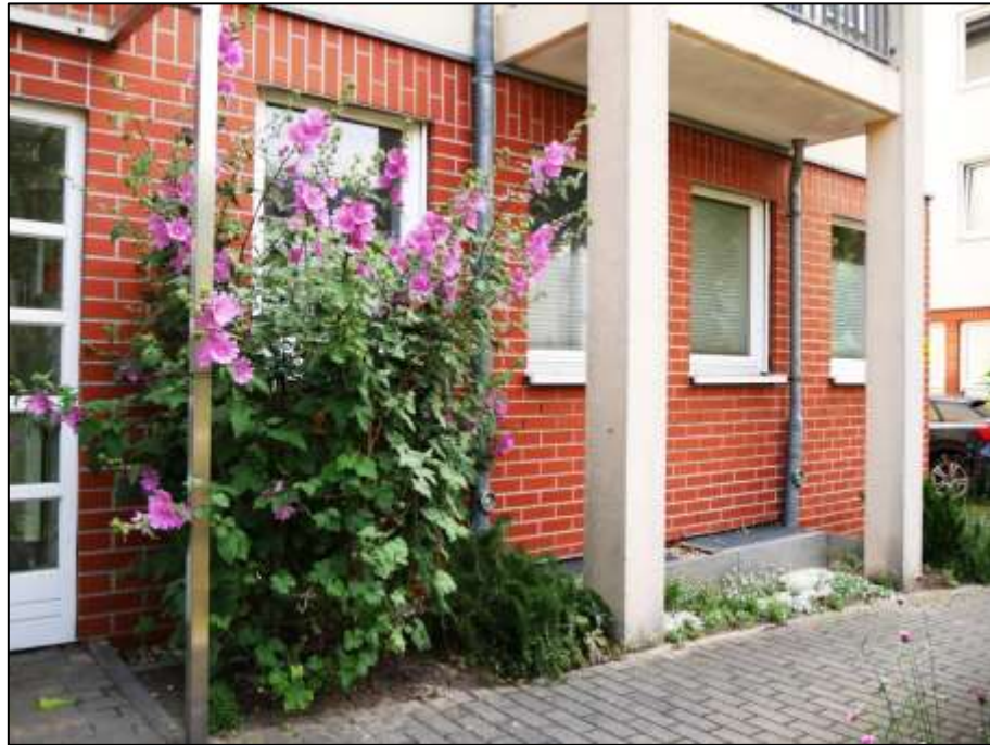
unmittelbar rechts neben der Hauseingangstür und hinter der Zugangsrampe unterhalb des Balkonvorbaus belegene Fensterfront des Wohnungseigentums Nr. 2 im Erdgeschoss als Maisonettewohnung im Erd- und Untergeschoss
