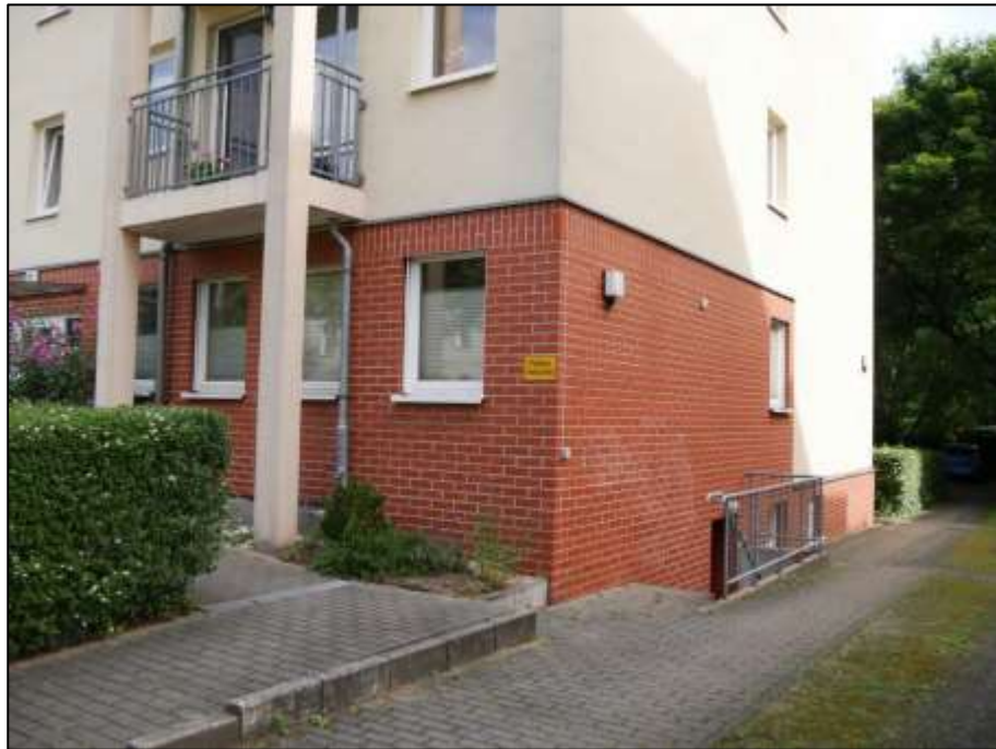
straßenseitige Front und freie Giebelseite des auf dem Grundstück Friedrich-Engels-Str. 22 aufstehenden Wohngebäudes im Bereich der Erdgeschosszone mit im Erdgeschoss und Untergeschoss als Maissonette belegtem Wohnungseigentums Nr. 2
