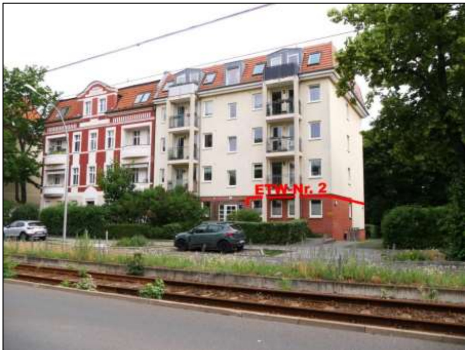
Blick über die Friedrich-Engels-Straße nach Norden auf das Grundstück Friedrich-Engels-Str. 22 mit im Erdgeschoss und Untergeschoss als Maisonette belegtem Wohnungseigentums Nr. 2
