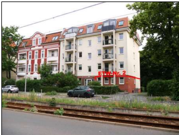
straßenseitige Gebäudefront mit ETW-Nr.2
