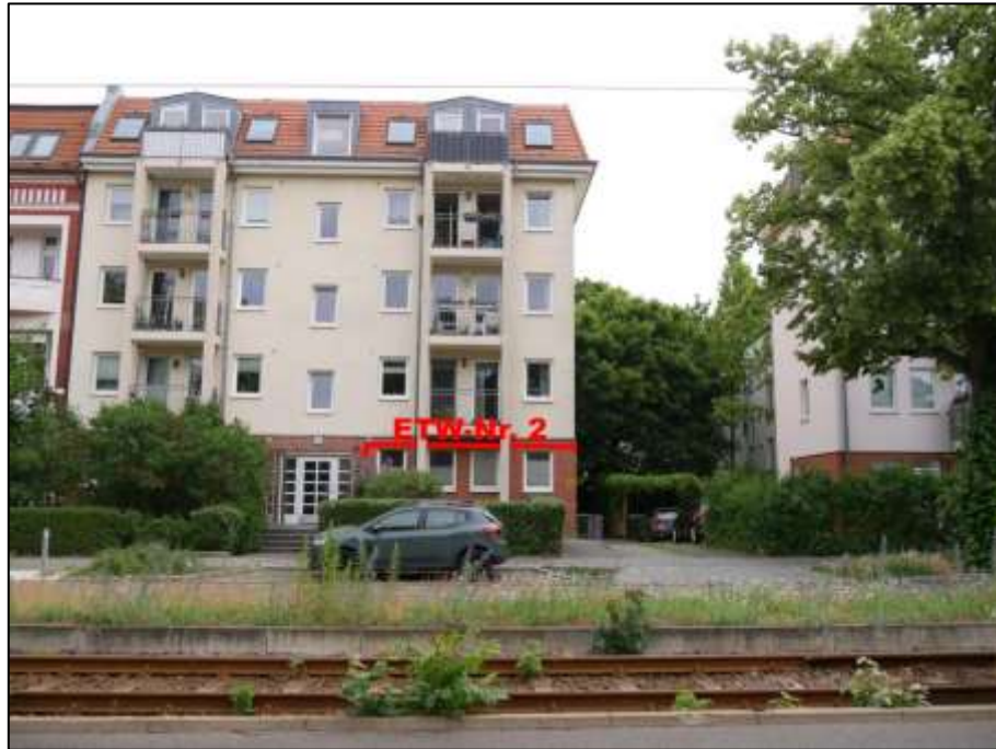
Blick über die Friedrich-Engels-Straße nach Nord-Osten auf das Grundstück Friedrich-Engels-Str. 22 mit im Erdgeschoss und Untergeschoss als Maisonette belegtem Wohnungseigentums Nr. 2
