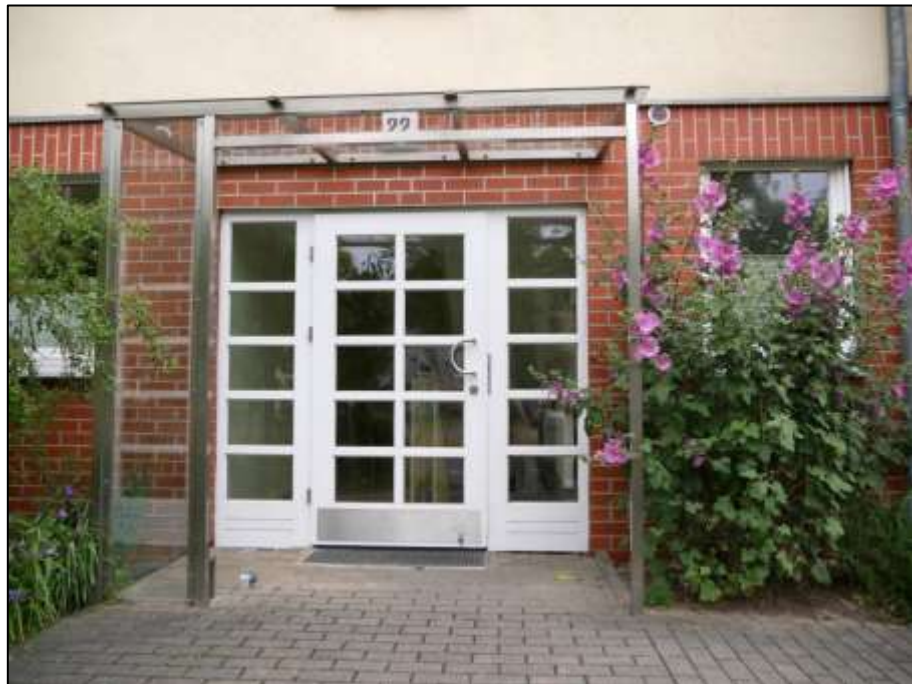
im Hochparterre belegene Hauseingangstür des Treppenhauses mit davor belegener gedeckter Podestfläche und rechts im Bild anbindender Rampe
