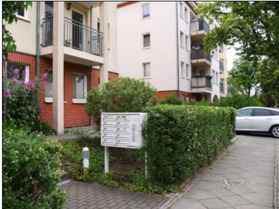
im Bereich der Hauszuwegung im Vorgarten installierte Briefkasten- und Klingelanlage des auf dem Grundstück Friedrich-Engels-Str. 22 aufstehenden Wohngebäudes mit daneben installierter Pollerleuchte
