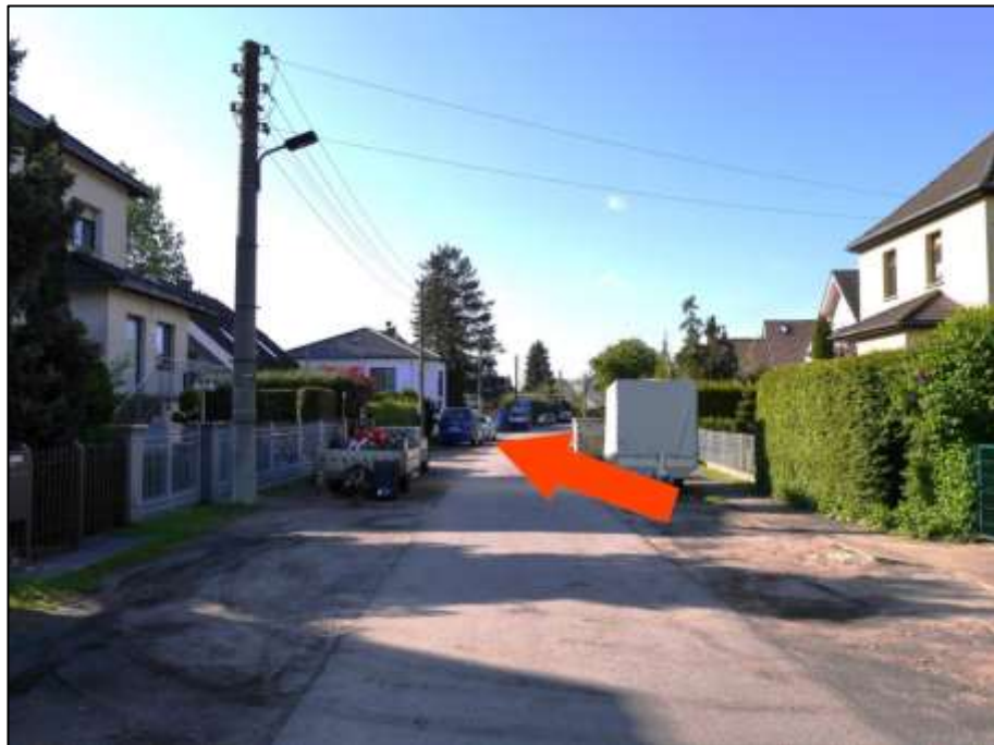
Blick in die Straße 31 nach Süden mit Lage des Grundstücks Nr. 10 auf der östlichen bzw. im Bild linken Straßenseite (Pfeil)
