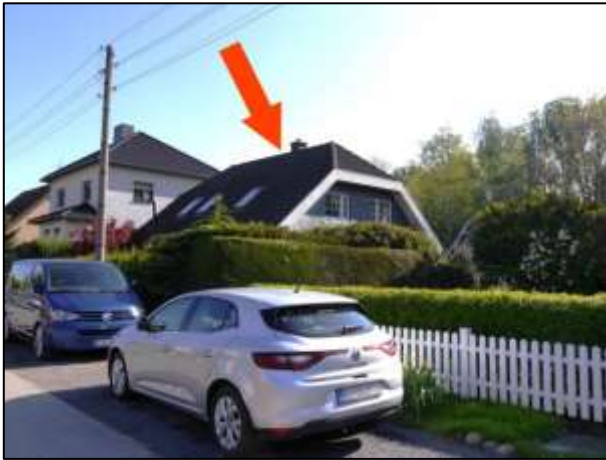
EFH auf dem Grundstück Straße 31 Nr. 10
