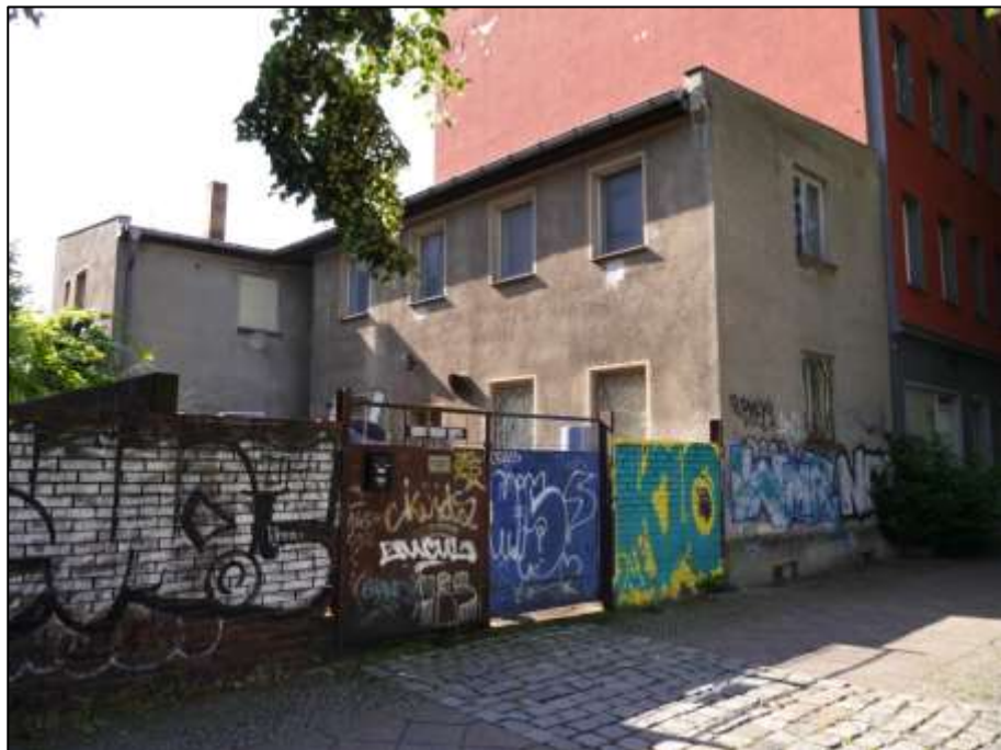
Blick aus der Friesickestraße auf die straßenseitige Einfriedung mit Torzufahrt auf den Hof des Eckgrundstücks Friesickestr. 19, Charlottenburger Str. 104 und den Geweretrakt auf dem Grundstück vor der hoch aufgehenden Grenzbebauung des Nachbargrundstücks
