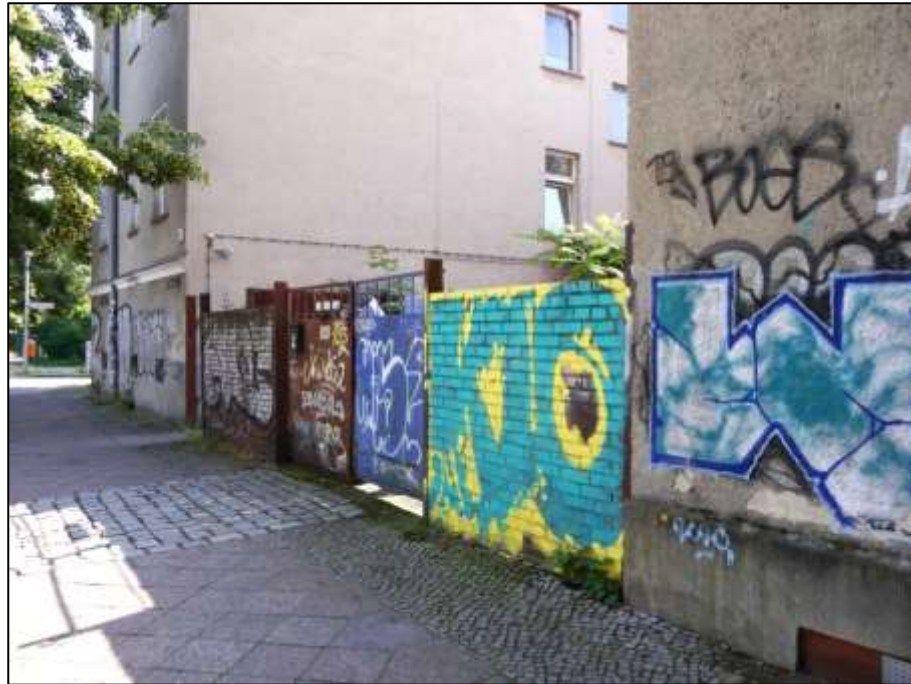
zur Friesickestraße orientierte Hofeinfriedung mit Toranlage zum Gewerbehof und Hauszuwegung vor der freien Giebelseite des Wohnhauses als Hauseingangsfront
