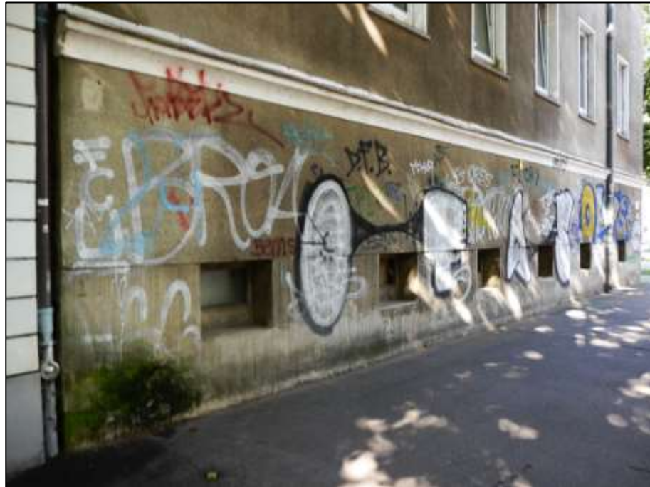
Gebäudesockel im Bereich des Souterrains an der zur Charlottenburger Straße orientierten Front des Wohngebäudes auf dem Eckgrundstück Friesickestr. 19, Charlottenburger Str. 104
