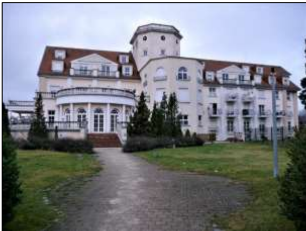
Blick von der Brodau Straße aus
