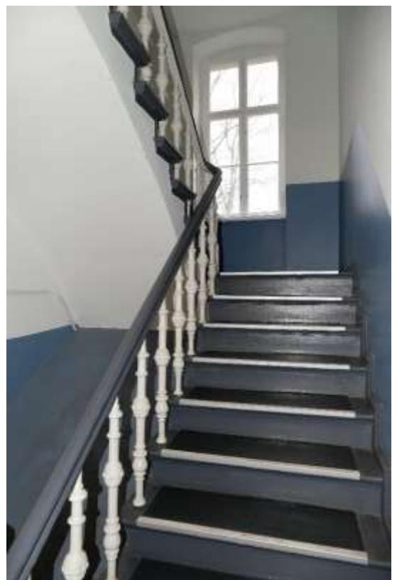
GartenhausDurchgang und Treppenhaus
